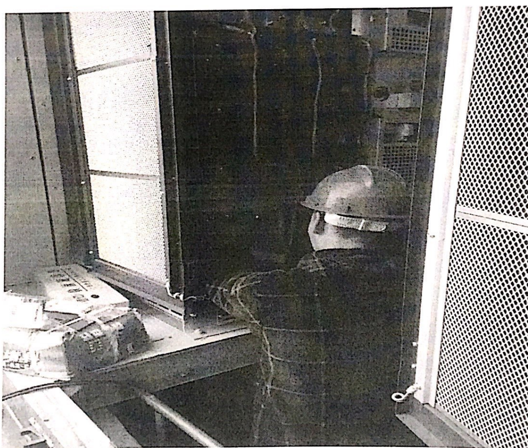
2、3#箱逆变设备端热缩电缆头制作安装
