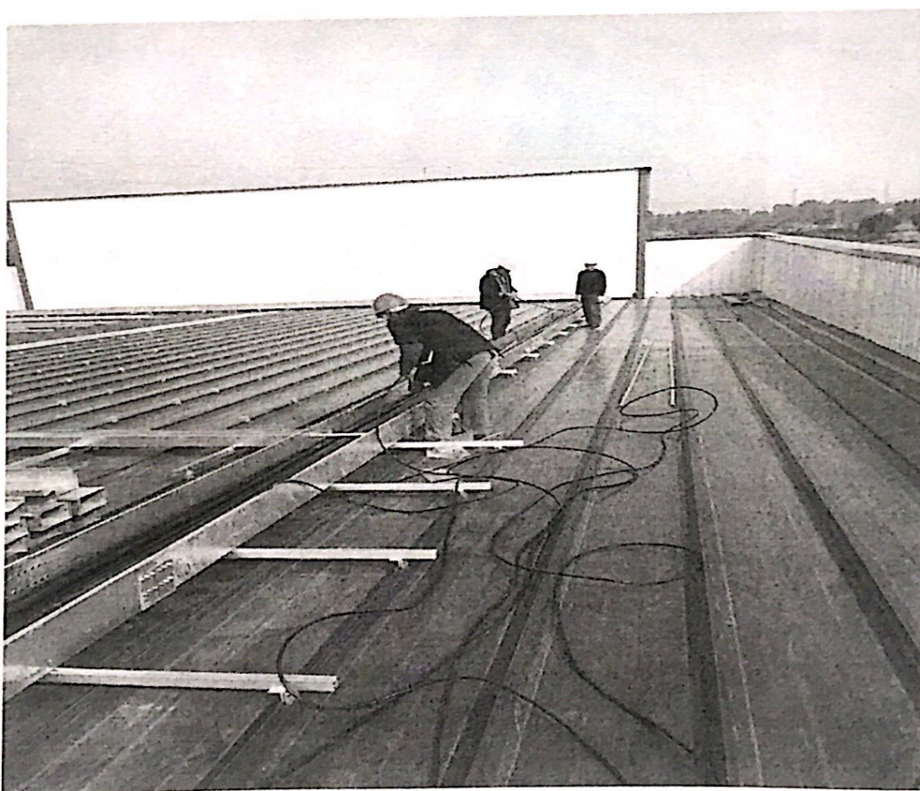
4#屋面光伏区 485 通讯电缆敷设穿管
