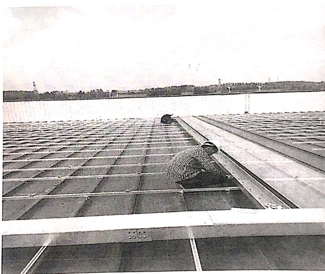
4#屋面光伏区电缆桥架安装
