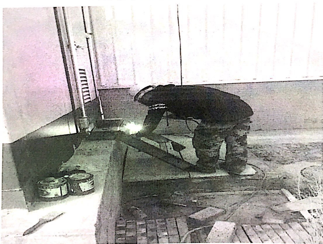
箱逆变基础、一、二次预制舱基础外爬梯焊接
