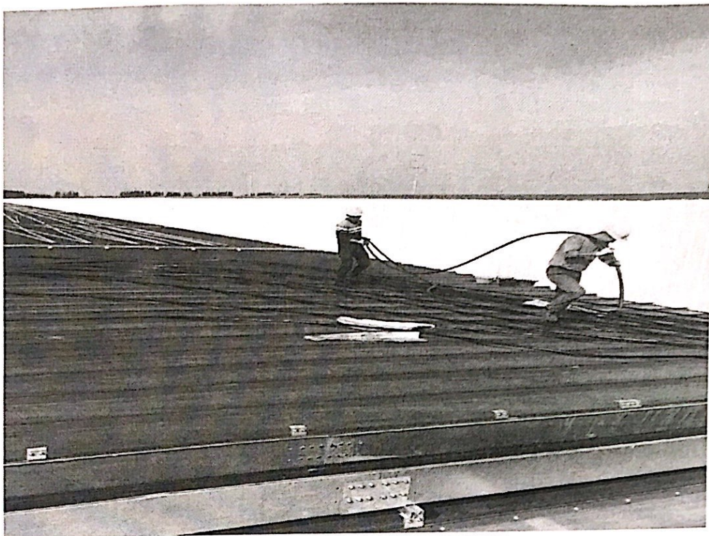
4#屋面光伏区 2*95 直流电缆敷设
