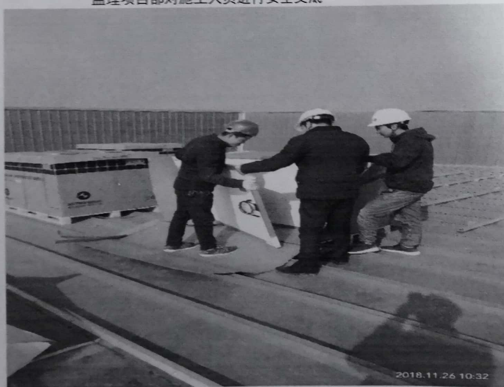
组件开箱检查
