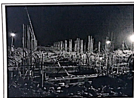
钢筋模板制作安装
