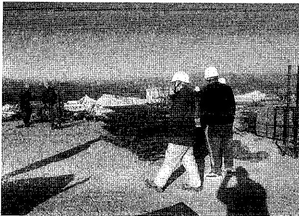
现场安全文明施工检查
