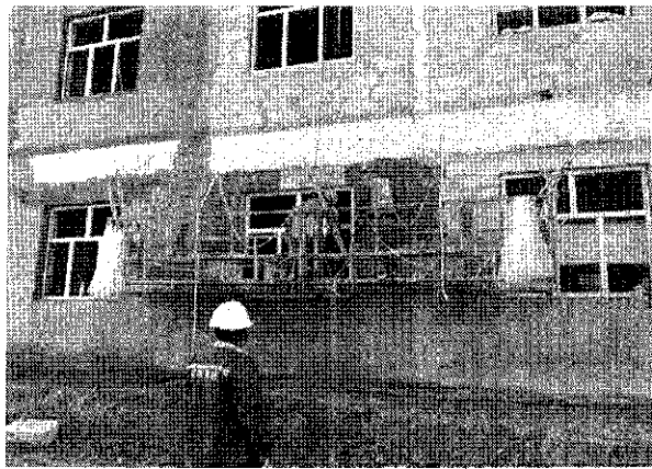
升压站外墙抹灰施工
