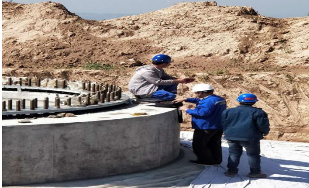
F32风机基础电阻测试20190617
