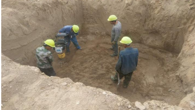
F21风机箱变基础灰土打夯施工20190618
