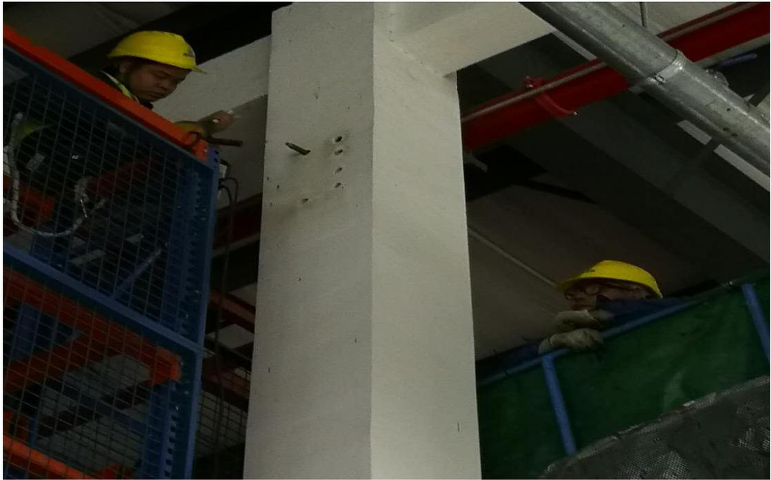
固定钢板打螺栓孔
