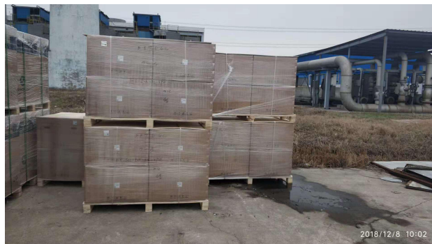
逆变器到场 26 台
