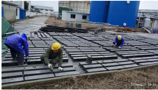
支墩模具拆除
