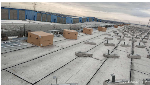
逆变器搬运至屋面
