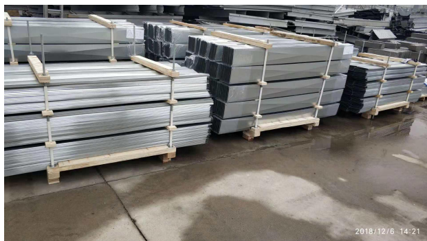
支架挡板到场
