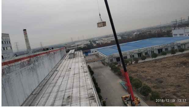
屋面组件吊运
