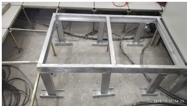
开关柜基础制作
