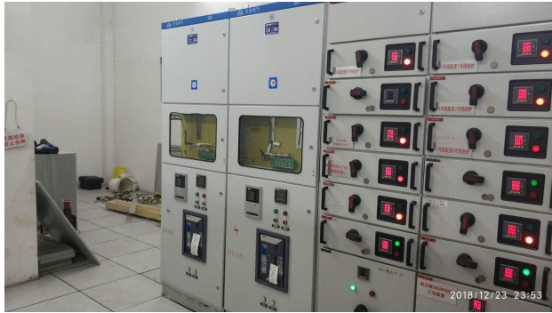
开关柜就位完成
