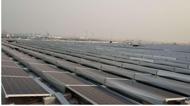
组件当班安装
