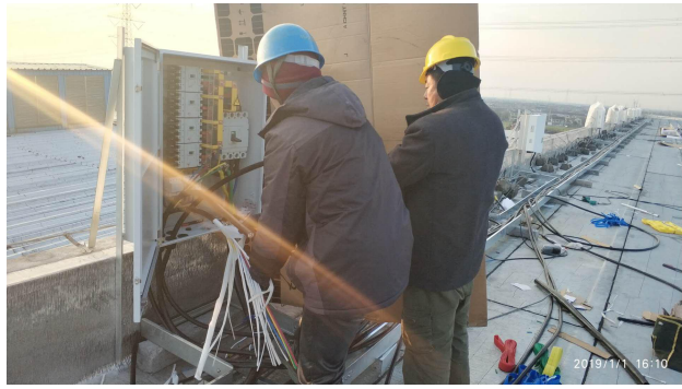
逆变器安装接线
