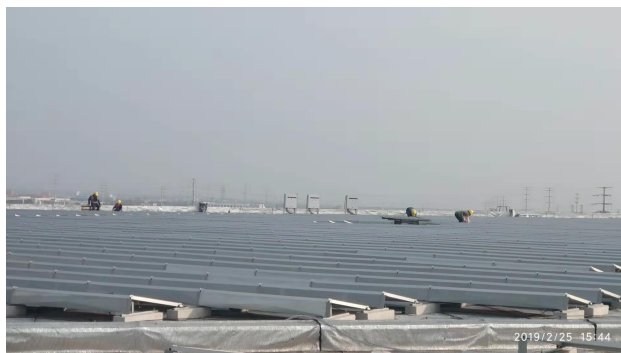
挡板安装完成 35%
