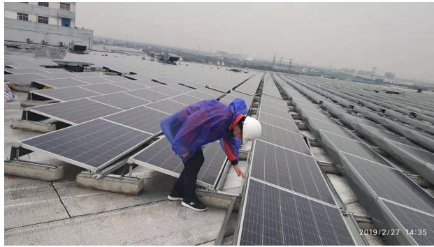
挡板安装检查
