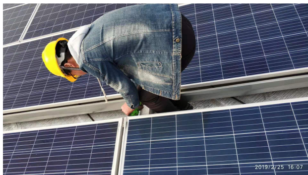
挡板安装施工
