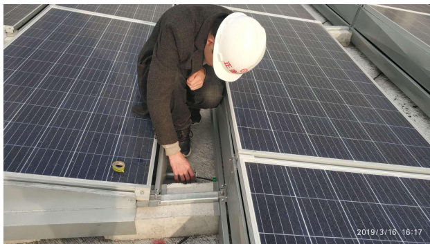
1×4 mm 2 光伏线套管检查
