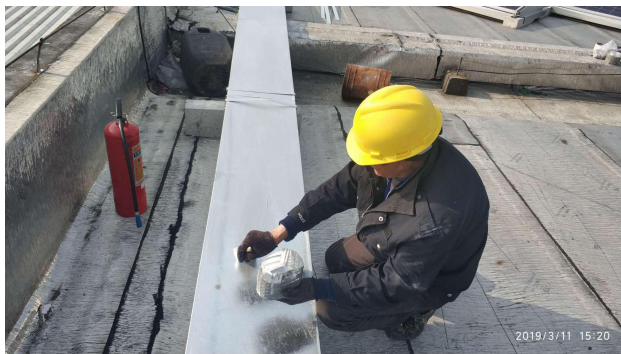
桥架盖板污渍刷漆整改
