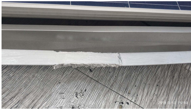
接地焊接面刷漆
