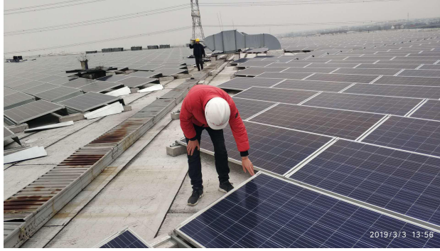
挡板安装检查
