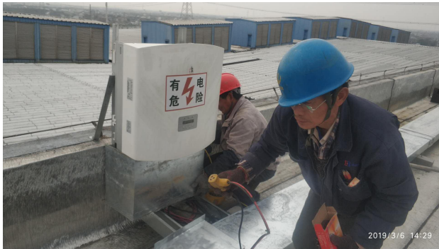
逆变器端口电缆桥架盖板制作
