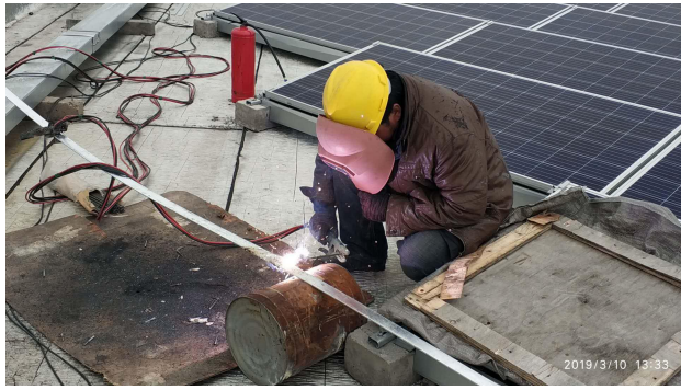
接地焊接施工
