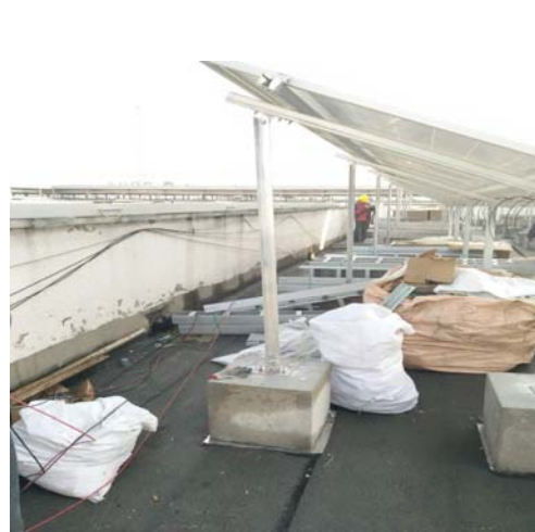
敷设直流电缆
