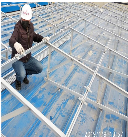
检查支架安装质量
