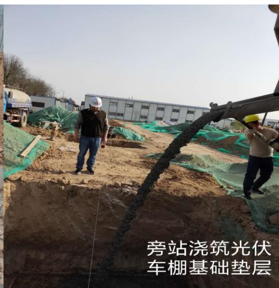
浇筑光伏车棚基础垫层
