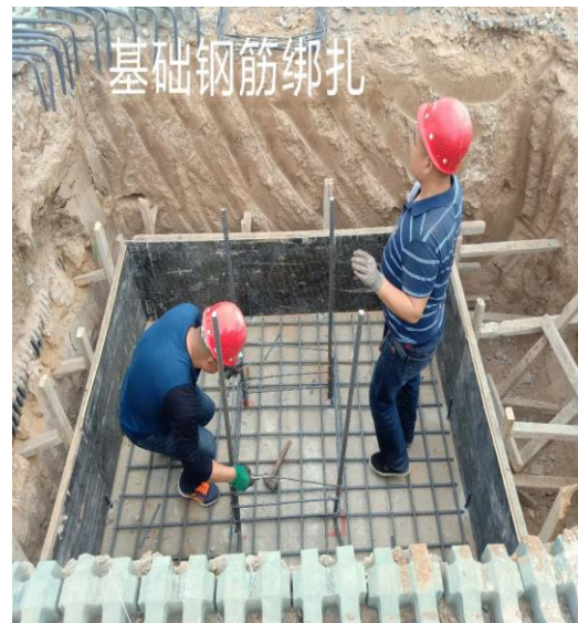
绑扎光伏车棚基础钢筋
