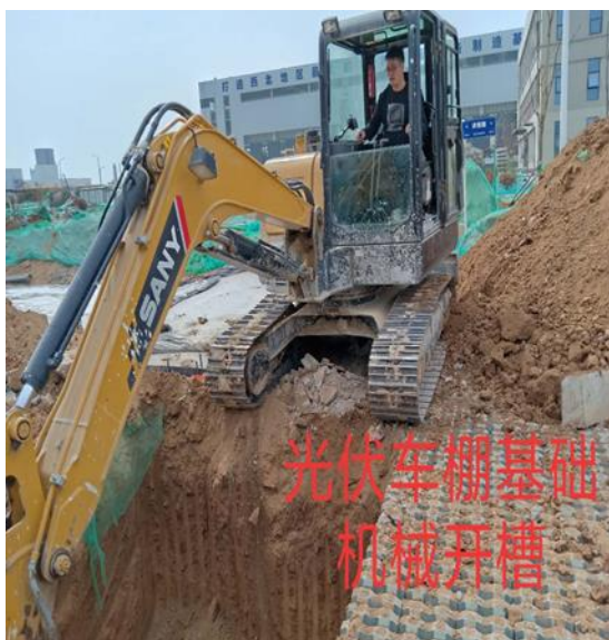
光伏车棚基础开槽
