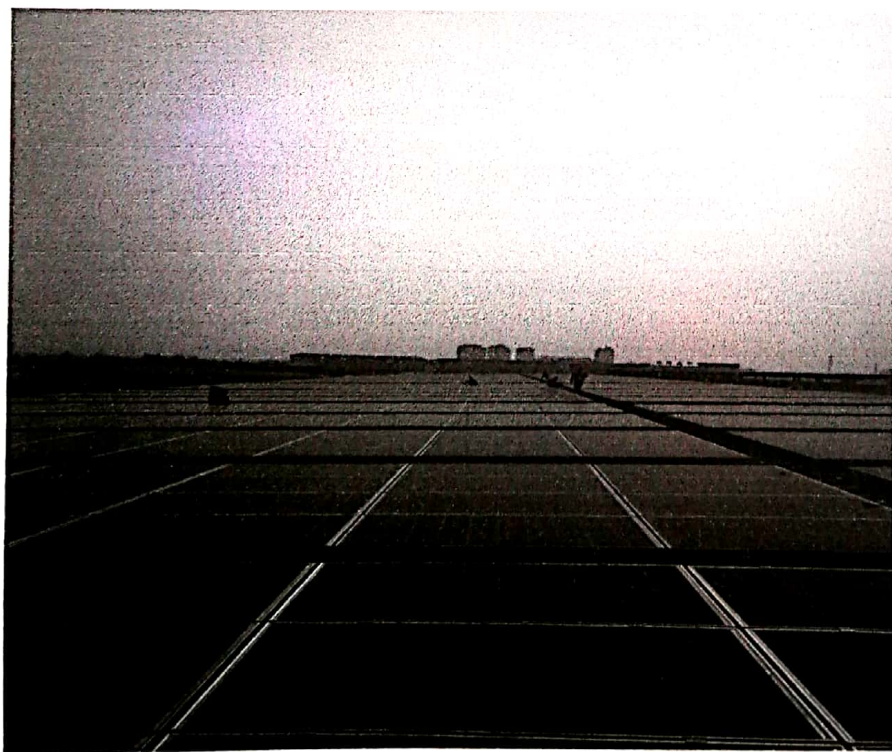
7#厂房组件安装
