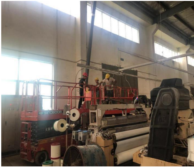
边柱斜撑安装
