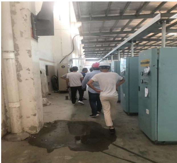
组织项目部人员 对厂房加固进行 过程检查
