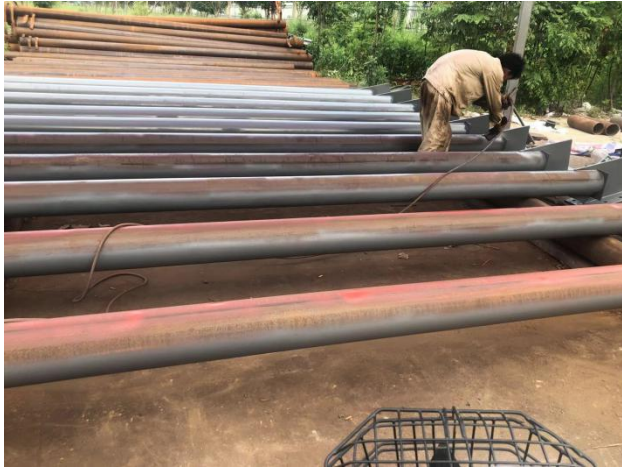
检查斜撑焊接及 涂装质量情况
