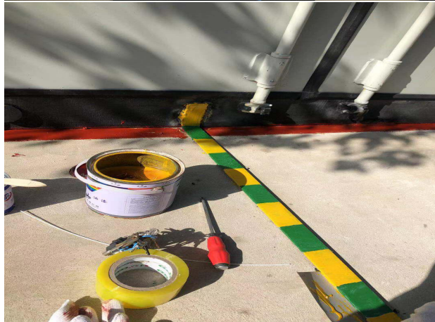
设备基础接地涂 刷黄绿漆
