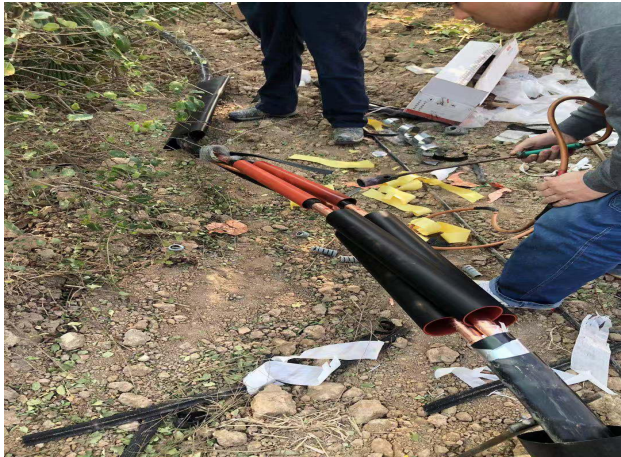
南线上杆电缆头 制作
