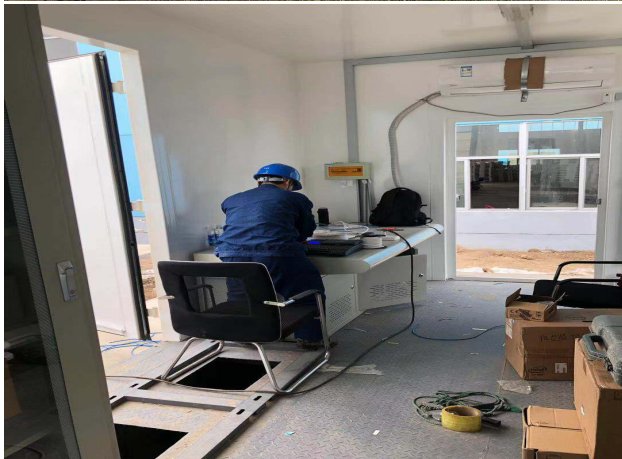
二次接线调试
