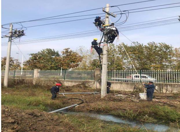
北线上杆断路器 安装
