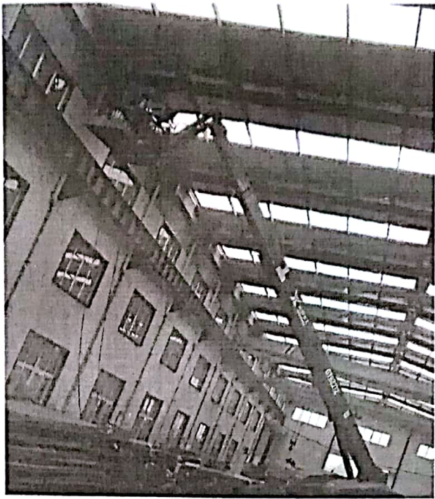
加固自修整修
