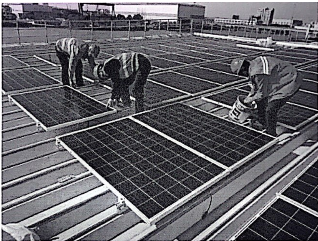
1#屋面组件安装
