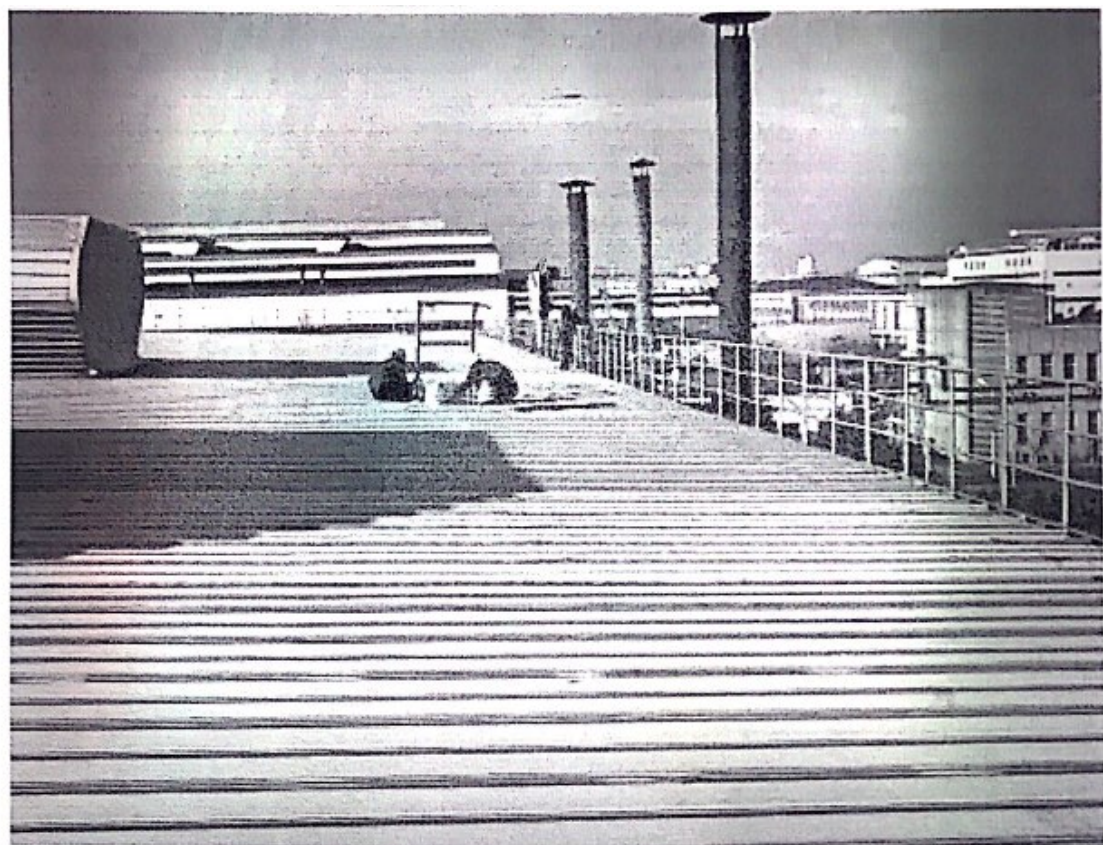
2#屋面逆变器支架安装
