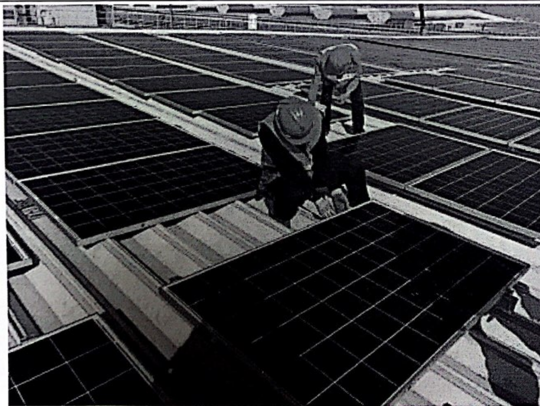
2#屋面组件安装
