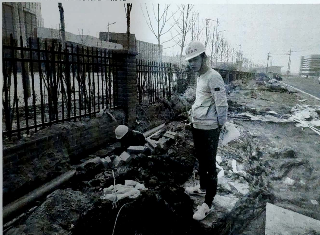
检查喜临门项目电缆井施工情况
