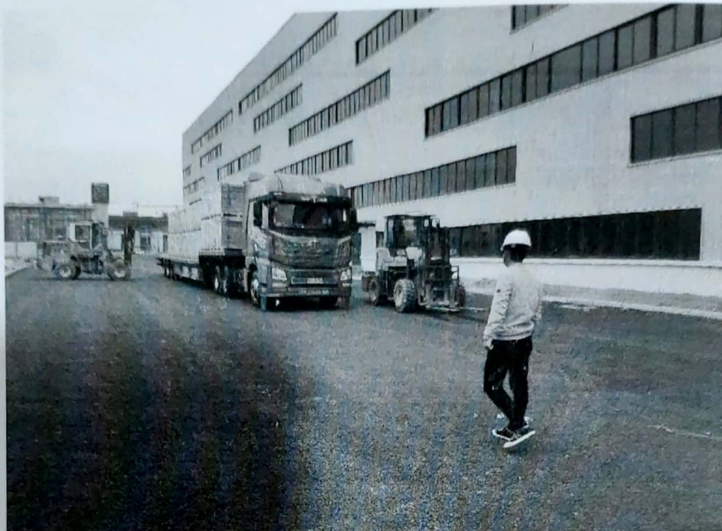
喜临门项目光伏组件第一次进场，现场检查并确认到货数量，并开箱检查。
