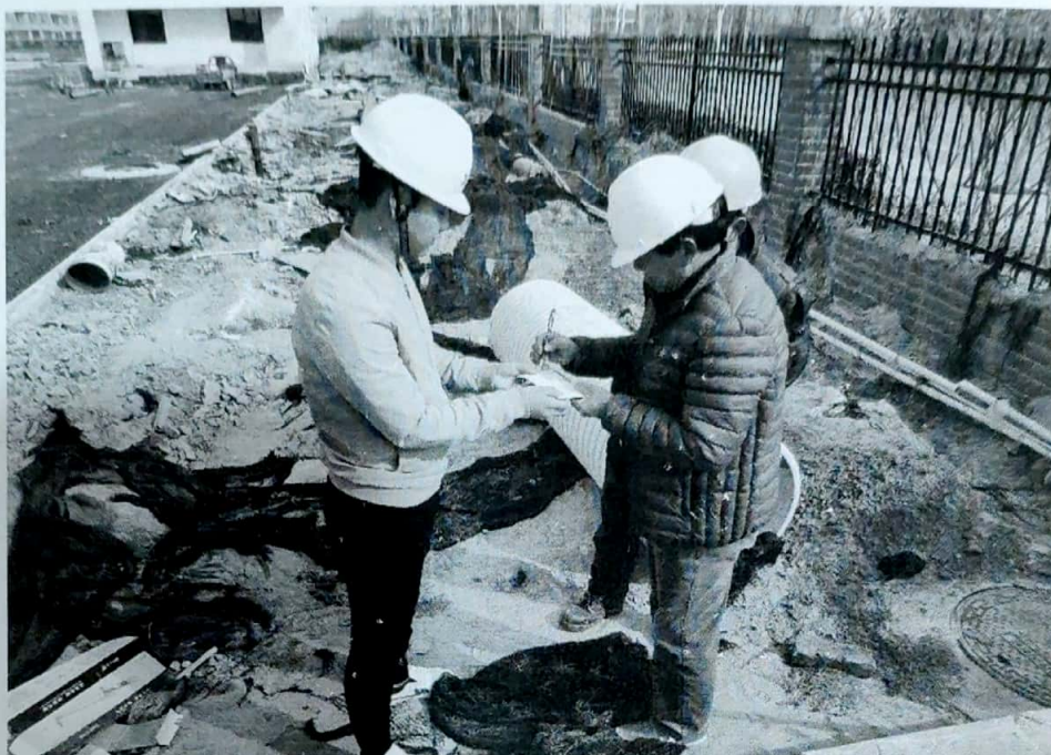
喜临门项目安全技术交底培训后，现场施工人员签字确认。
