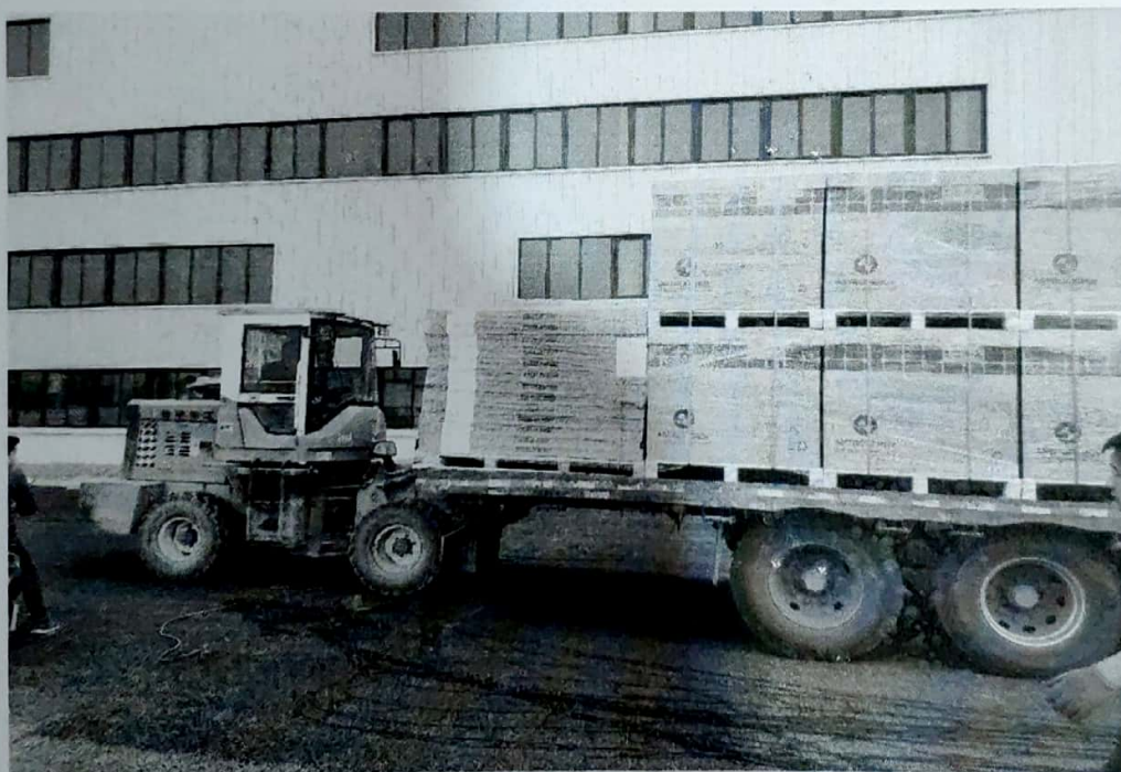
喜临门项目光伏组件第二次进场，现场检查并确认到货数量。
