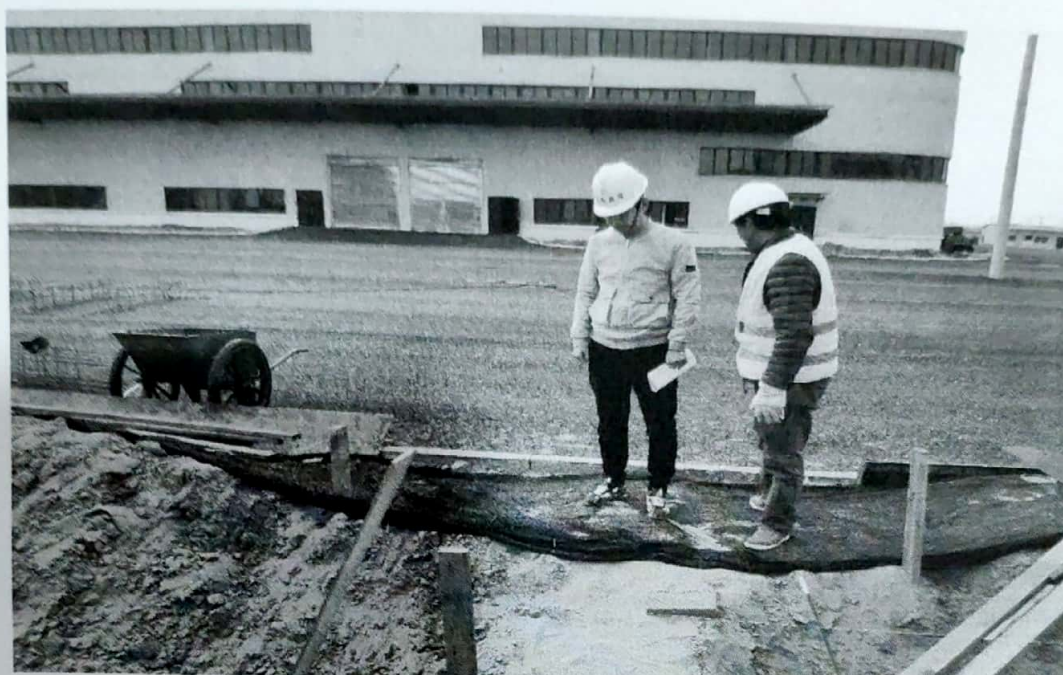
巡视检查喜临门项目现场施工情况
