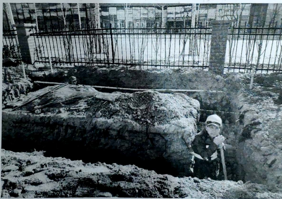
1#箱变基础土方开挖
