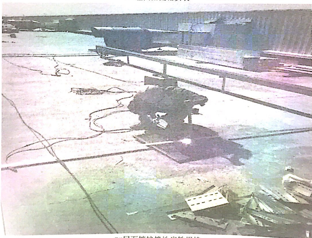
7#屋面镀锌接地扁铁焊接
