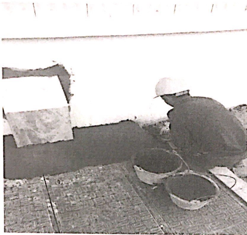
7#屋面下墙桥架空洞封堵
