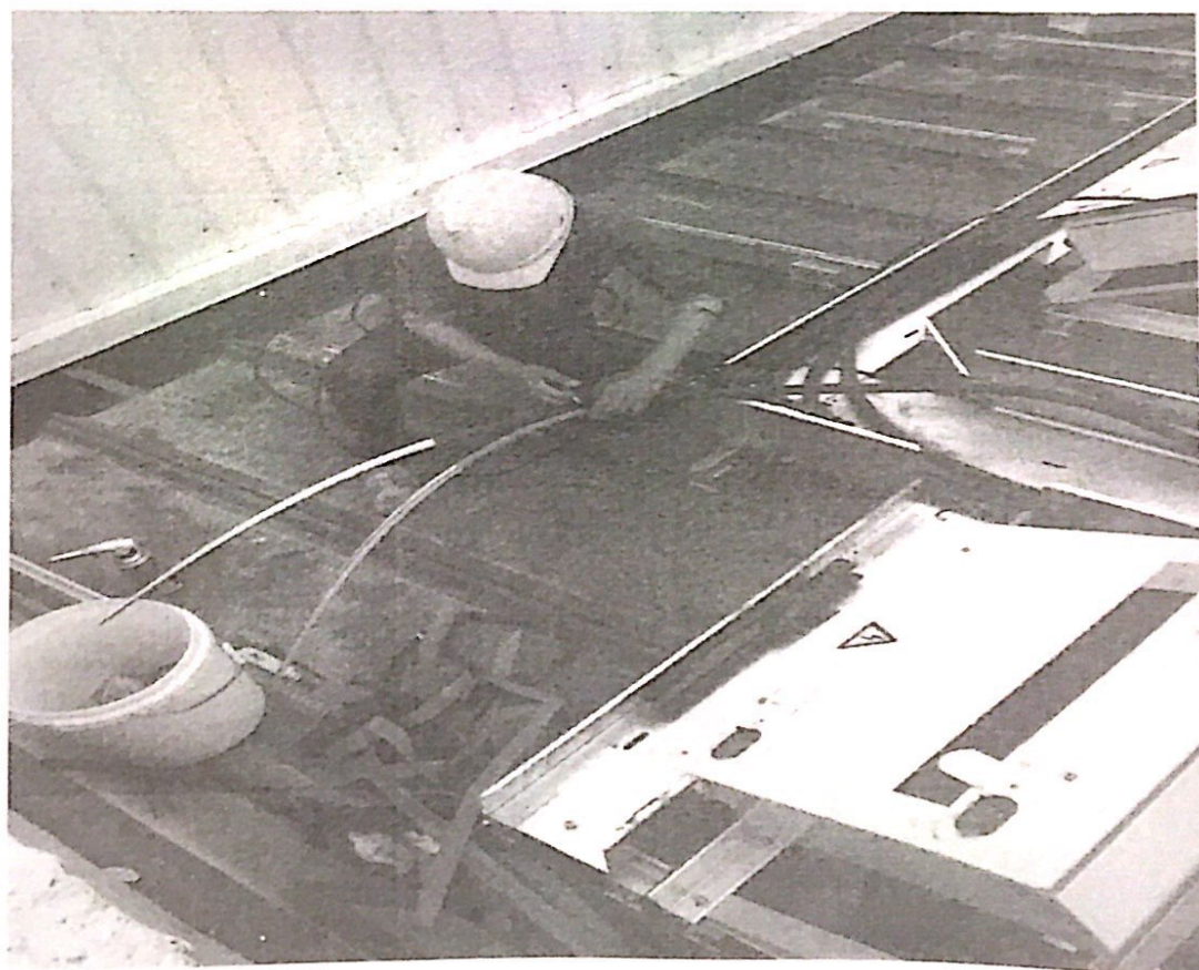
7#屋面汇流箱端热缩电缆头制作
