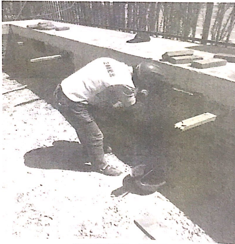
一次艙基礎內抹灰、安裝百葉窗
