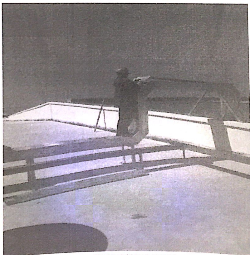
7#屋面电缆桥架盖板安装
