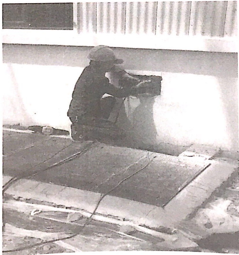
7#屋面下墙桥架开孔
