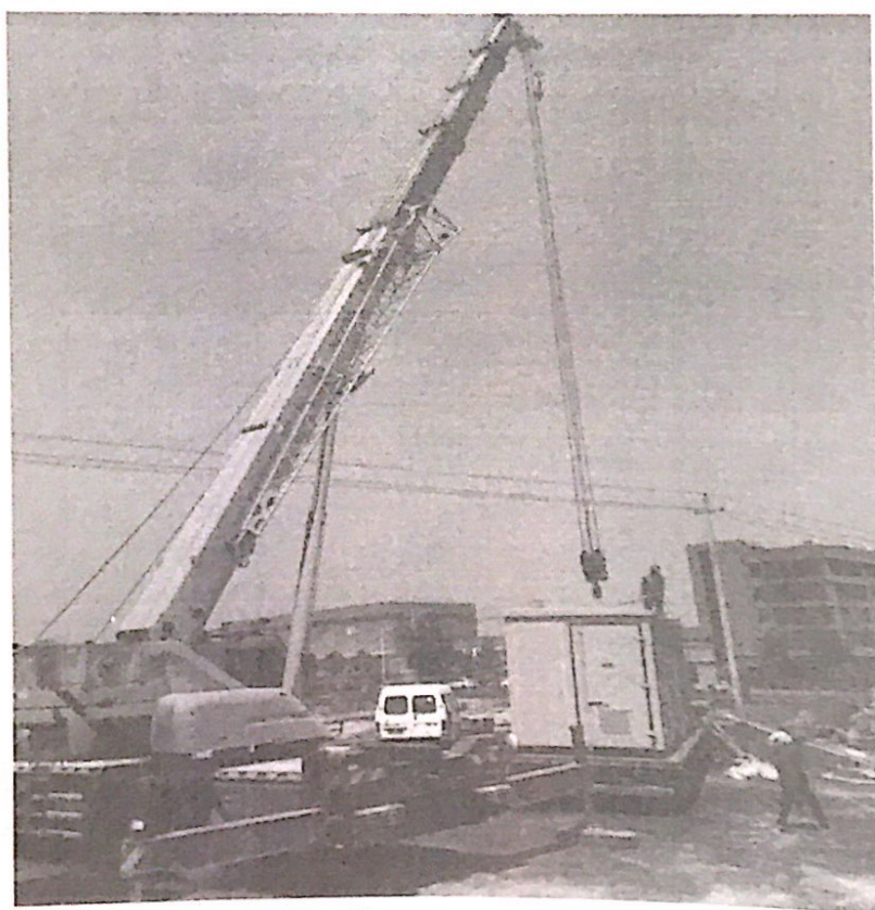
一次舱设备进场调运，监理人员现场旁站
