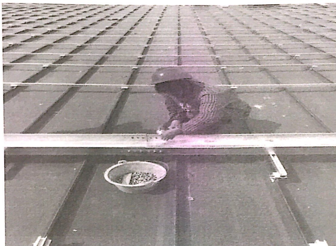
11#屋面电缆桥架安装
