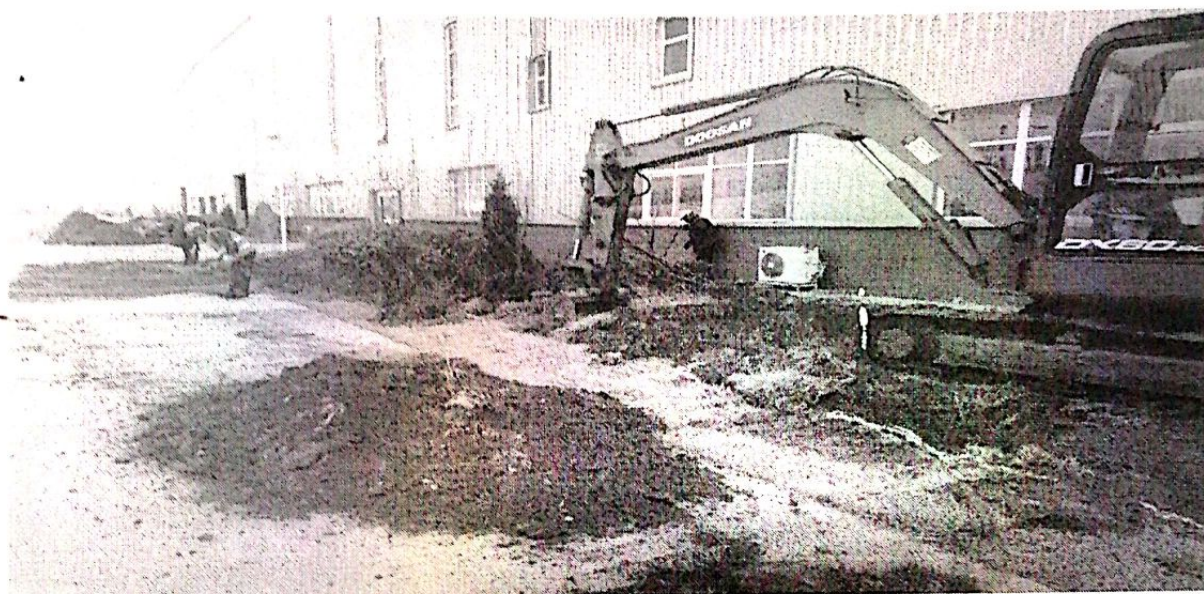
设备基础开挖
