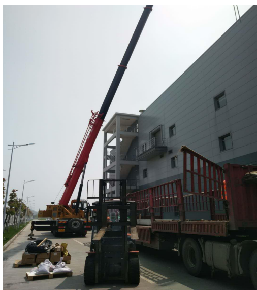
3 号楼吊装支架
