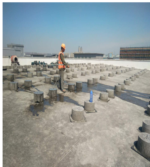
2 号楼水泥基础胶浇水养护
