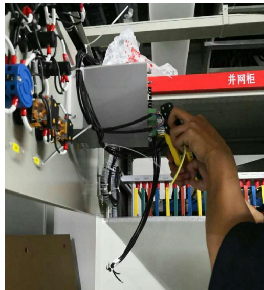
3 号楼配电室安装电能检测装置
