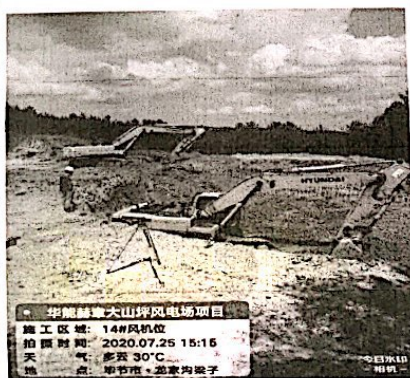
14#风机基础开挖
