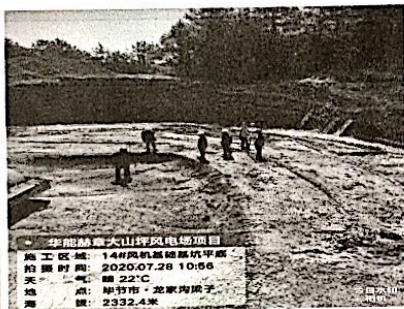
14#风机基础验槽
