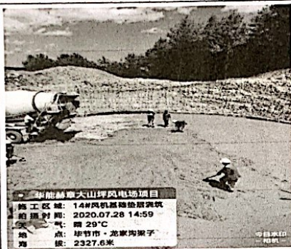
14#风机基础垫层浇筑监理旁站
