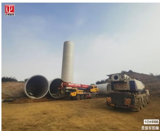
17#机位第一段塔筒吊装完成
