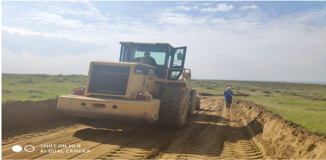
现场 A 道路清表施工
