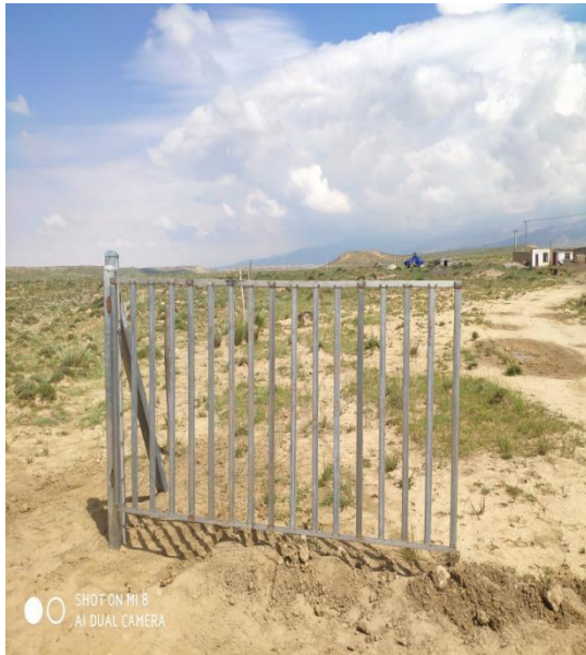
场区路口安全门安装
