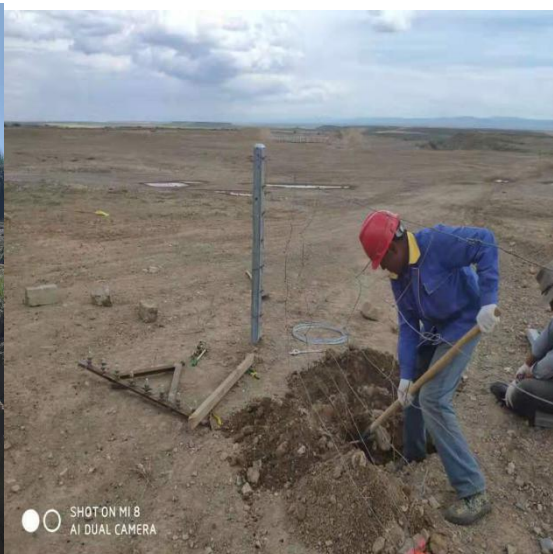
现场 C 道路临时移动门安装施工
