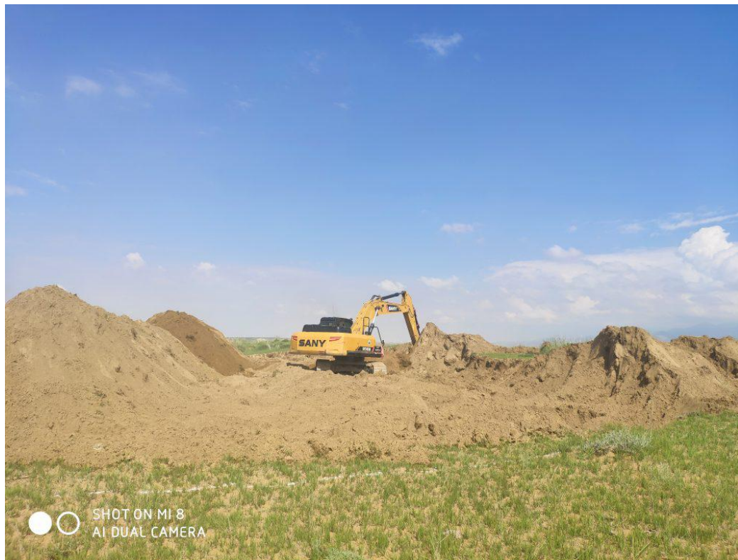
现场 15 号风机吊装平台施工
