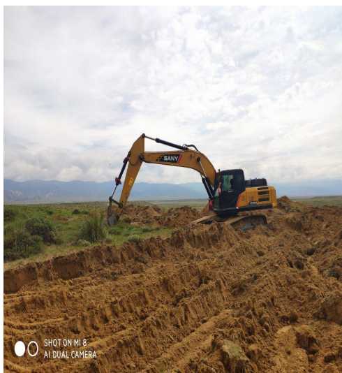
现场 16 号风机吊装平台施工
