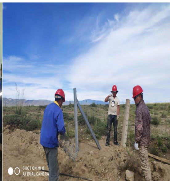
现场 C 道路进出口围网、移动门安装
