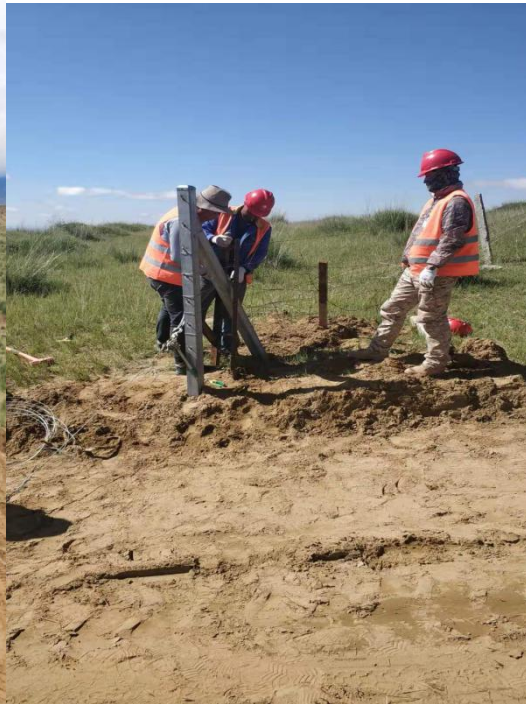
现场 A 道路入口处移动门施工
