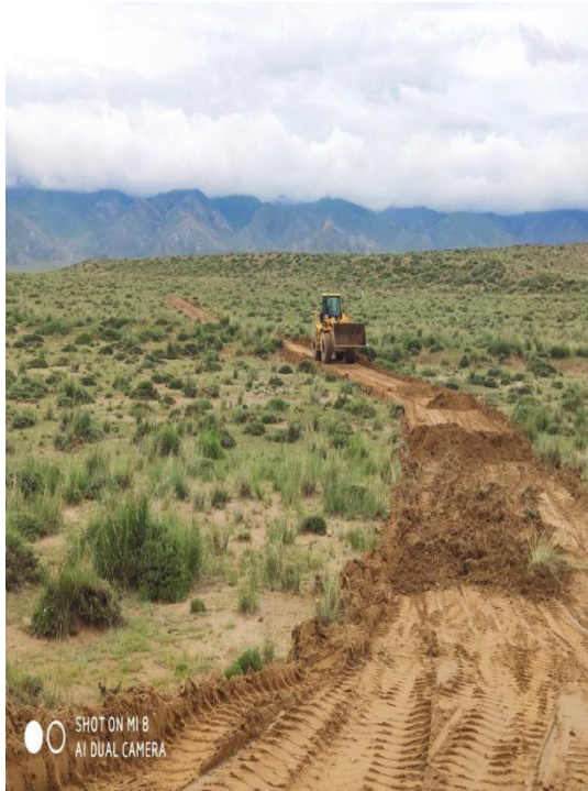
现场 A 道路施工
