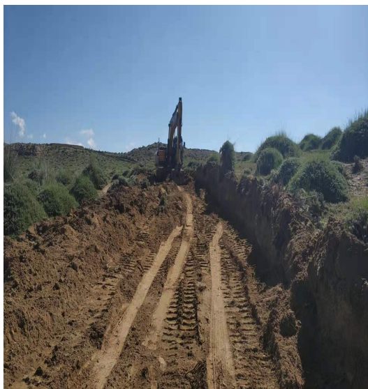
现场 A 道路挖机施工
