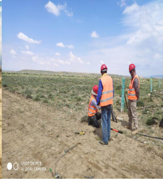
路口安全门施工
