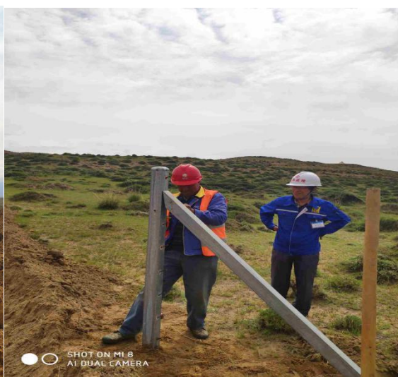
巡视检查场区入口处临时门安装
