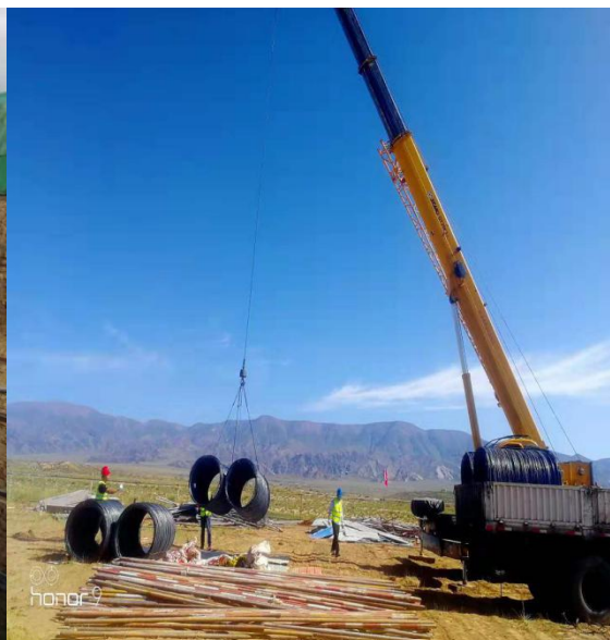
钢筋材料进场吊装
