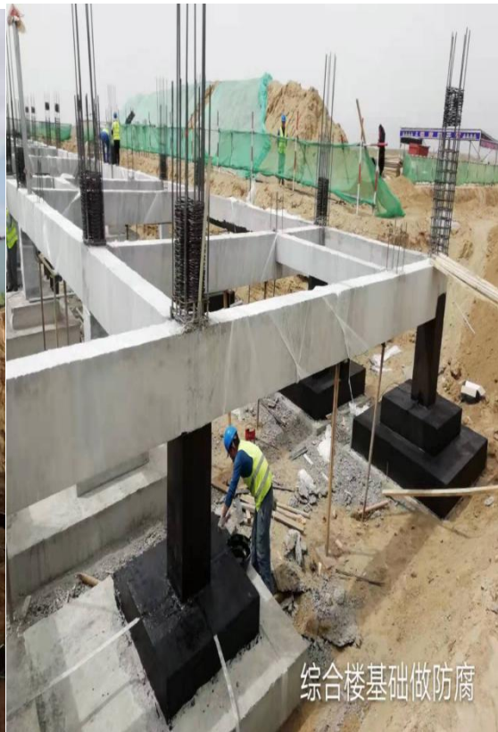
综合楼基础做防腐
