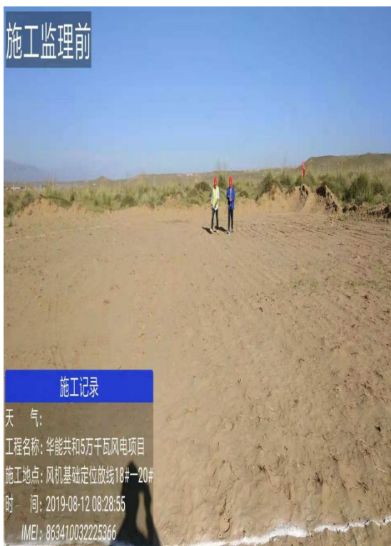
现场 18#-20#风机基础定位放线
