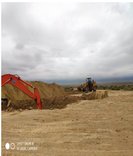
现场 13#风机基础开挖
