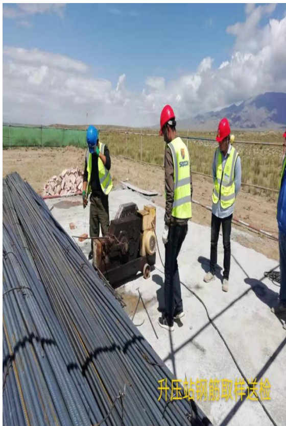
升压站钢筋取样送检
