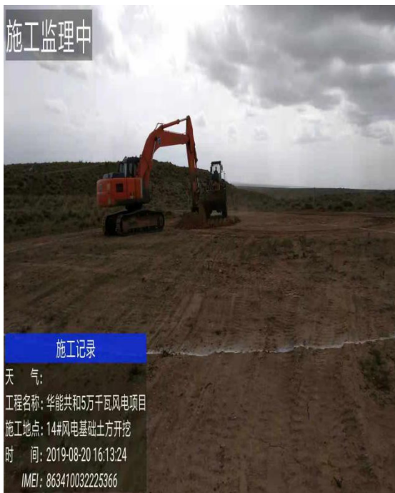
现场 14#风机基础土方开挖
