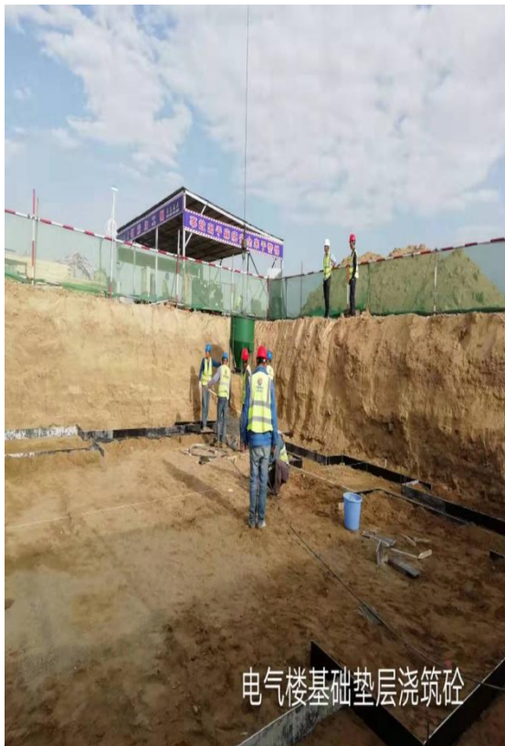
升压站电气楼基础垫层浇筑砼
