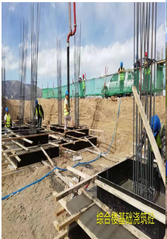
综合楼基础浇筑砼
