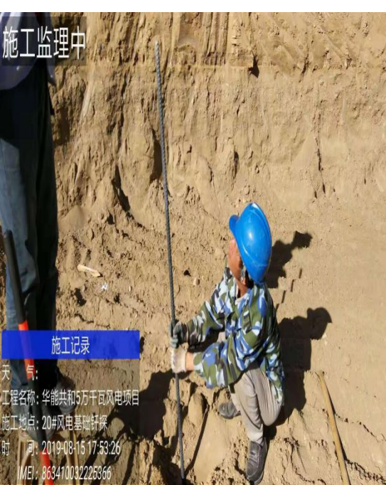
现场 20#风机基础钎探
