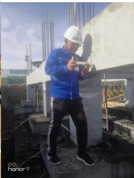
检查综合楼基础地梁混凝土回弹强度
