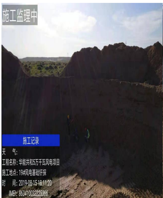
现场 19#风机基础钎探
