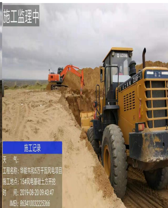
现场 15#风机基础土方开挖
