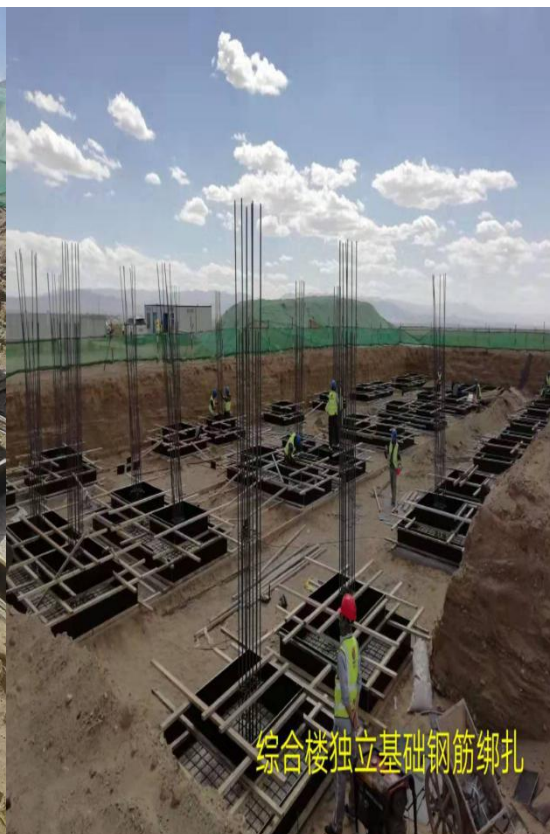
综合楼独立基础钢筋绑扎
