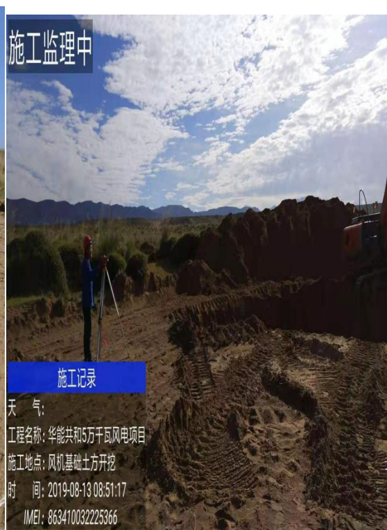
风机基础土方开挖
