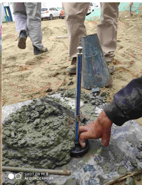
混凝土塌落度检查
