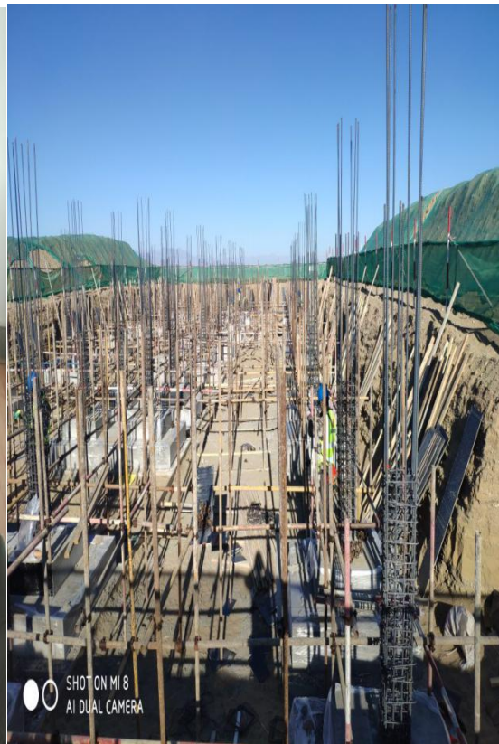
综合楼基础钢筋绑扎、支模
