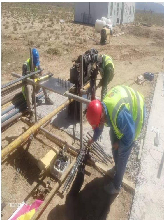
钢筋连接件取样
