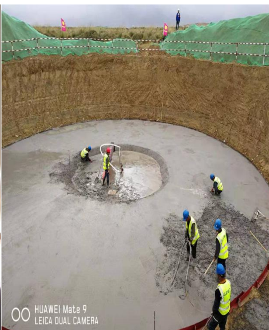
现场 20#风机基础垫层浇筑完成
