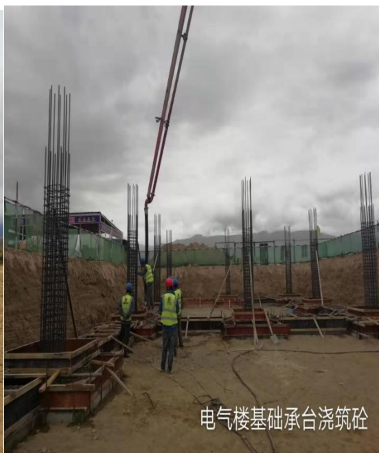
电气楼基础承台砼浇筑
