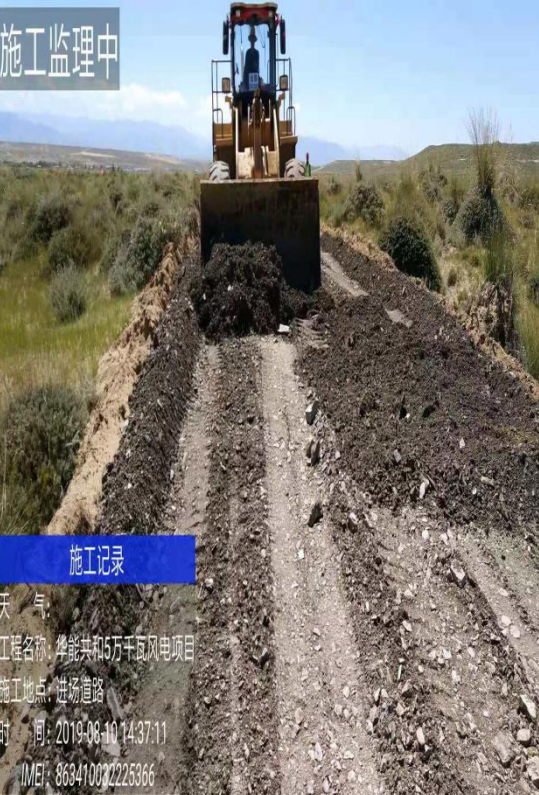
进场道路铺设砂石料施工
