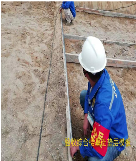
验收综合楼基础垫层模板
