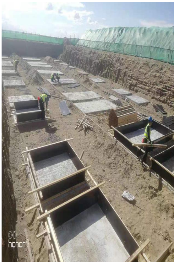
综合楼基础模板支撑施工
