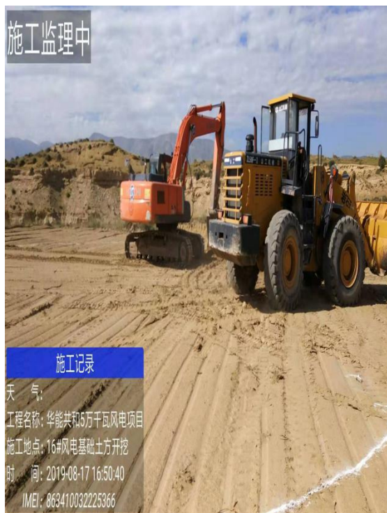
现场 16 号风机基础土方开挖
