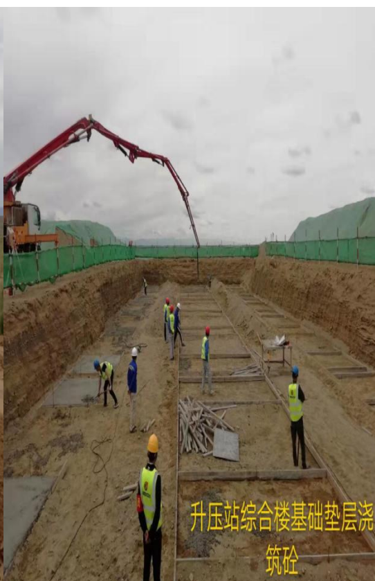
升压站综合楼基础垫层浇筑
