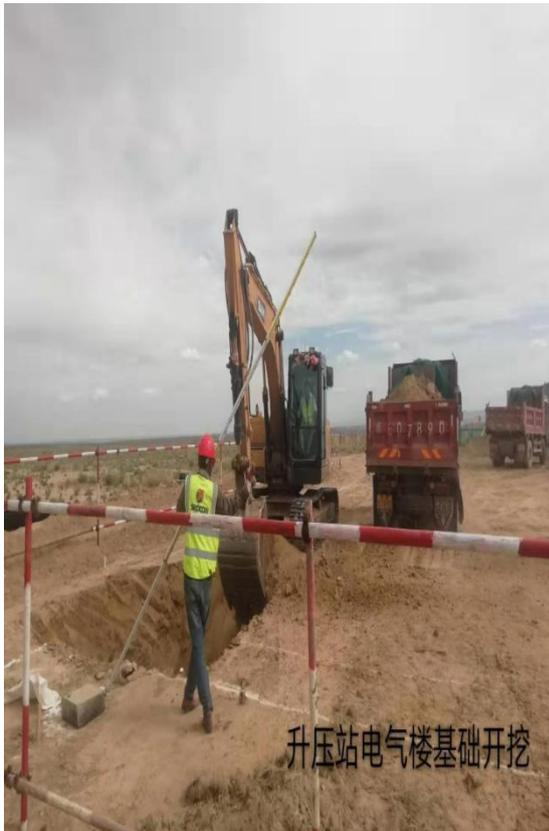
升压站电气楼基础开挖现场
