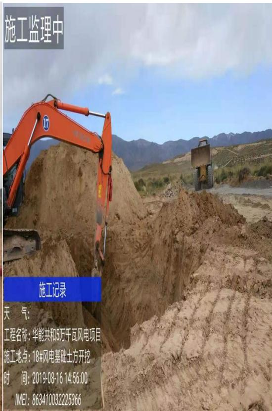
18号风机基础土方开挖
