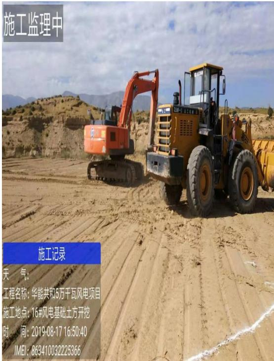
现场 16 号风机基础土方开挖
