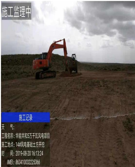
现场 14#风机基础土方开挖
