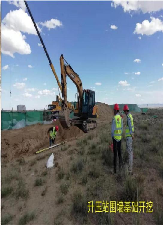
升压站围墙基础开挖
