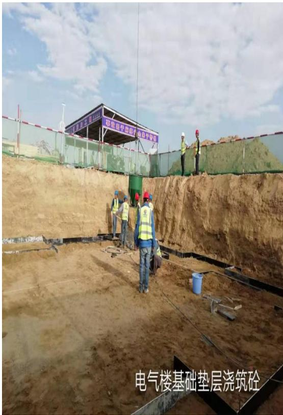
升压站电气楼基础垫层浇筑砼
