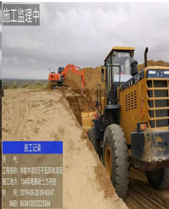
现场 15#风机基础土方开挖
