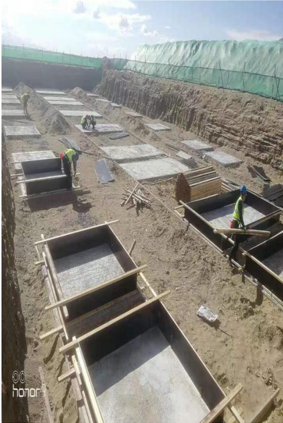
综合楼基础模板支撑施工
