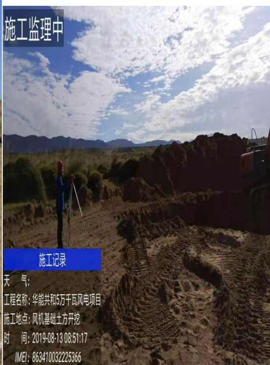
风机基础土方开挖
