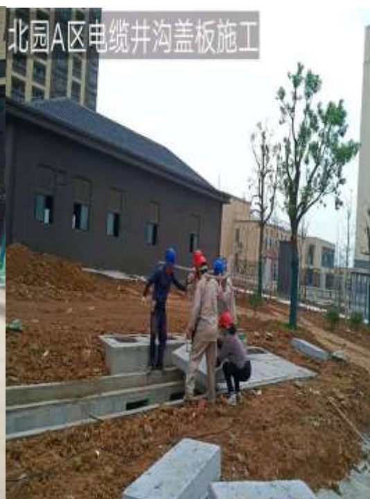
北园 A 区电缆井沟盖板施工
