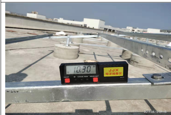
支架角度检查
