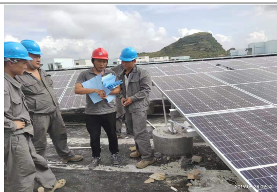
组件电缆敷设
