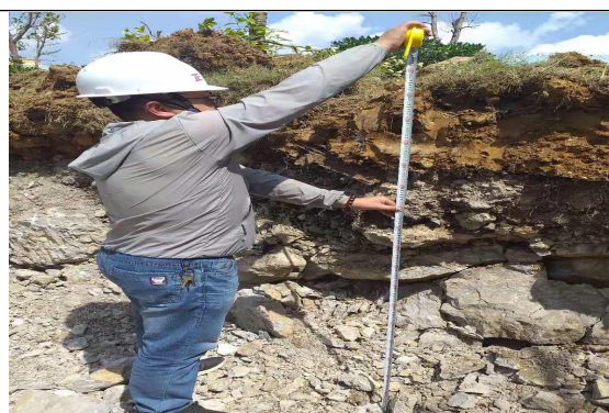
箱变基坑检查
