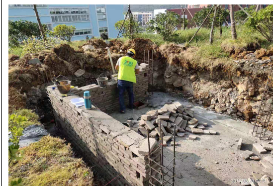
箱变主体砌筑
