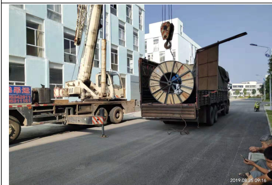
电缆到货吊装
