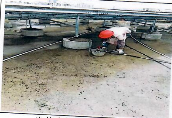
光伏支架基础二次灌浆
