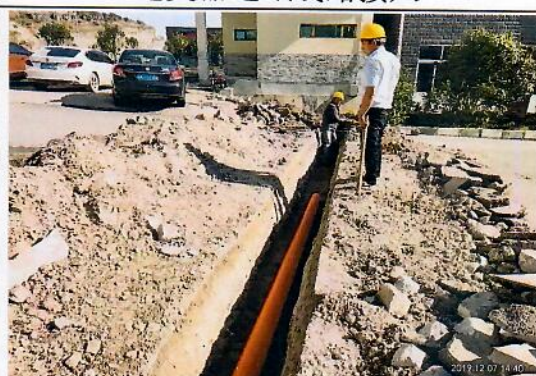
电缆沟过路开挖
