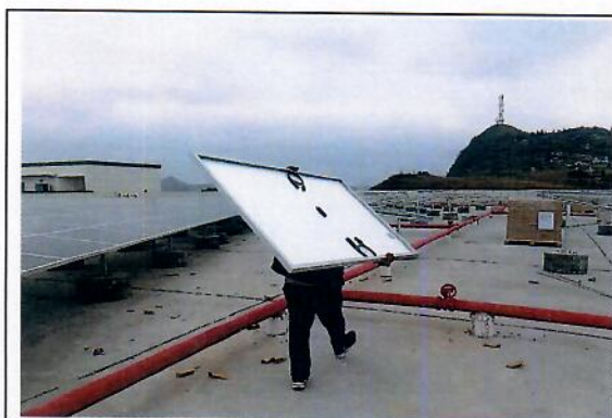
电池组件安装
