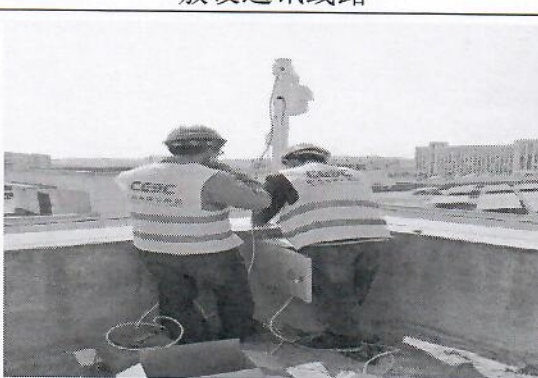
监控视频安装
