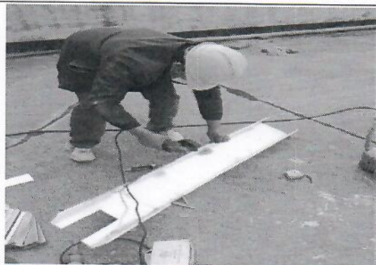
电缆槽盒制作
