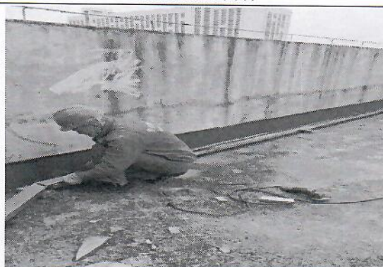
电缆槽盒安装
