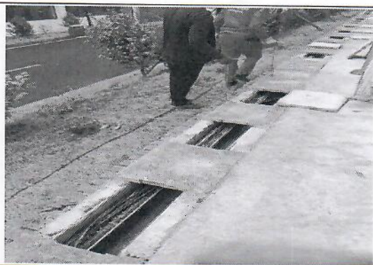
敷设通讯线路
