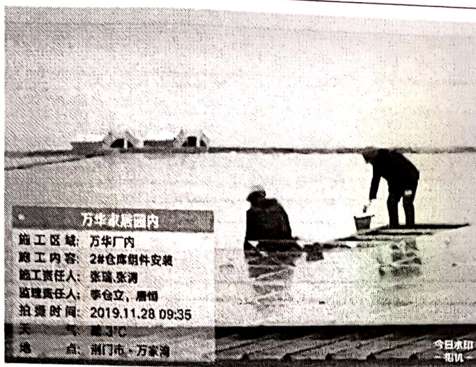
6、2#仓库组 件安装。
