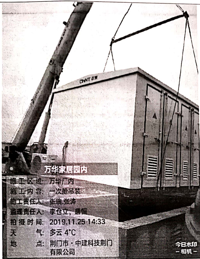
9、一次舱、 1#、2#、3#、 4#箱变吊装 就位。
