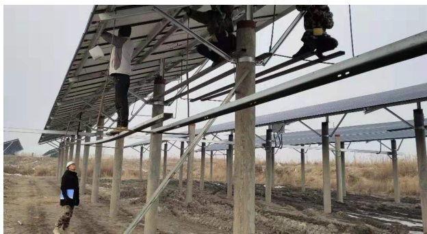
组件安装检查
