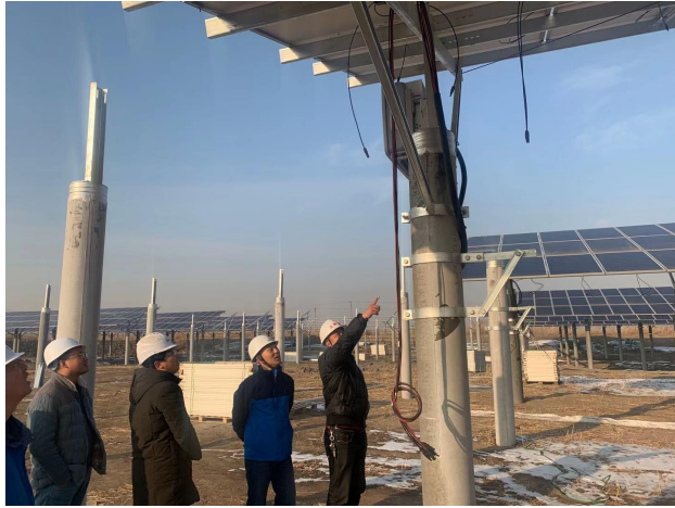
支架组件春节大检查
