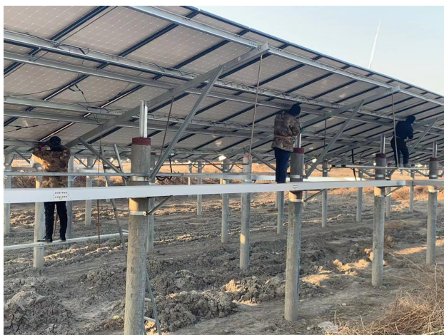
高庄组件安装整改
