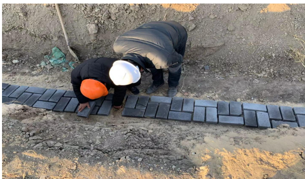
电缆沟铺沙盖砖
