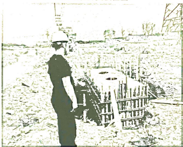
13#电缆井浇筑检查
