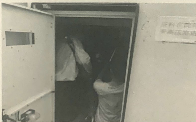
集电线路进入 27#箱变高压电缆头制作
