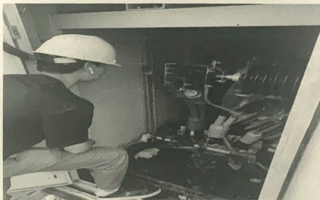
39#箱变集电线路高压电缆头制作
