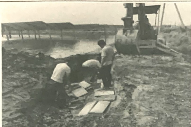
电缆沟铺沙盖砖
