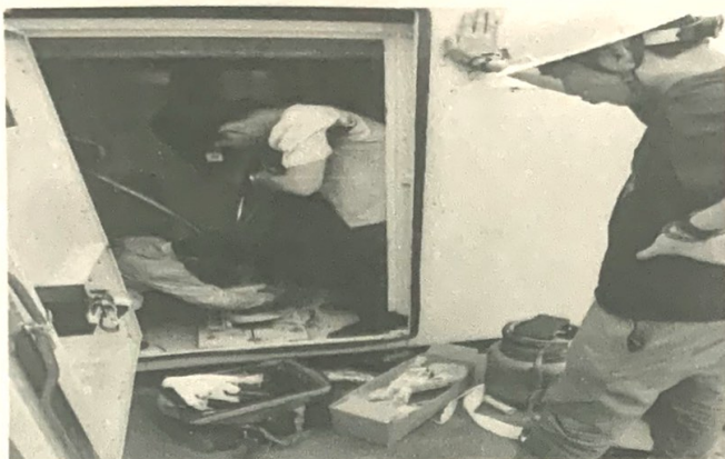
27#箱变集电线路高压电缆头制作旁站
