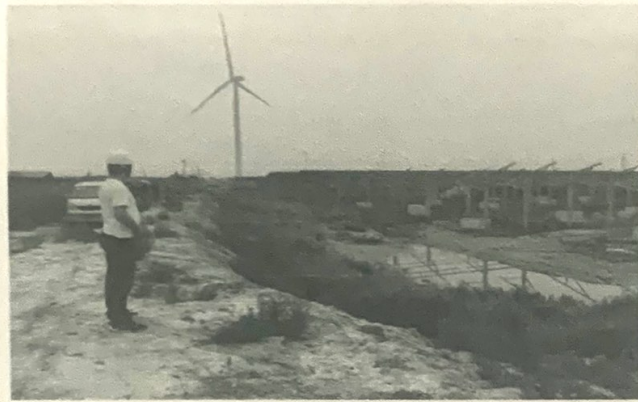
杨家泊支架安装
