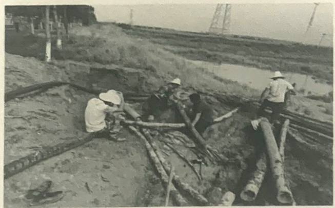
集电线路高压电缆敷设
