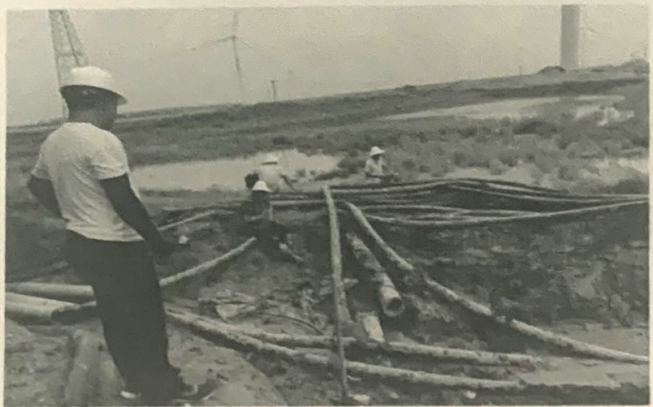
集电线路高压电缆敷设检查
