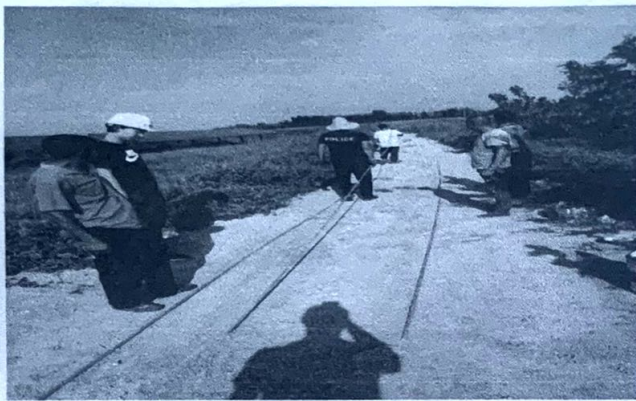
高庄接地施工
