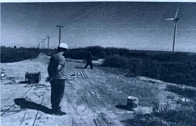
高庄接地施工检查
