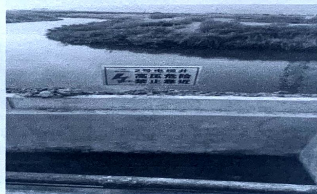
集电线路标牌施工
