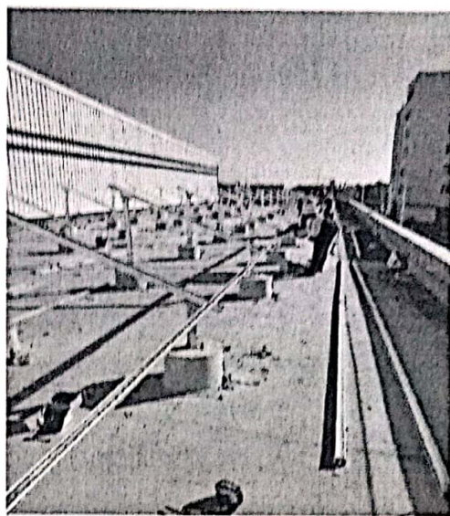
混凝土屋面支架安装
