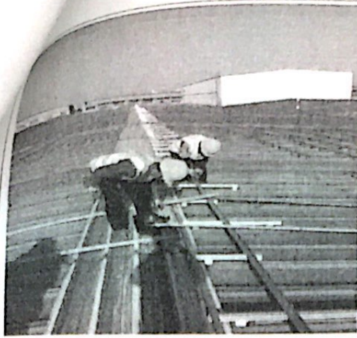
2019. 11. 12 桥架支架安装
