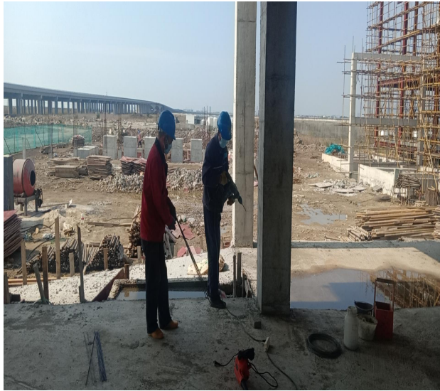
升压站综合楼柱植筋
