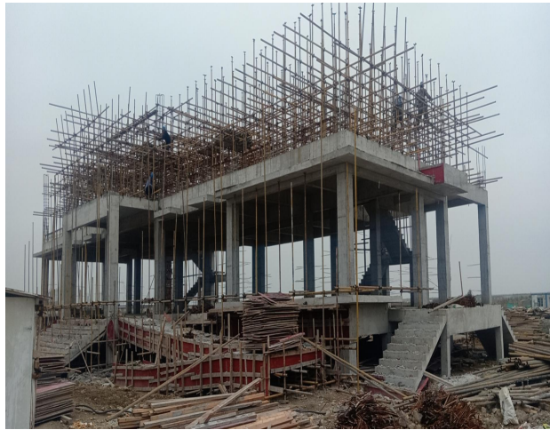
升压站综合楼二层满堂架搭设
