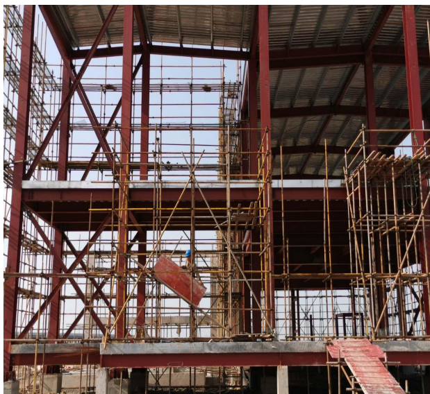
升压站配电楼二层辅道铺设
