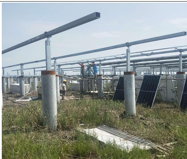
光伏区 36#组件安装
