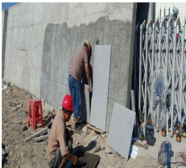
升压站大门贴花岗岩
