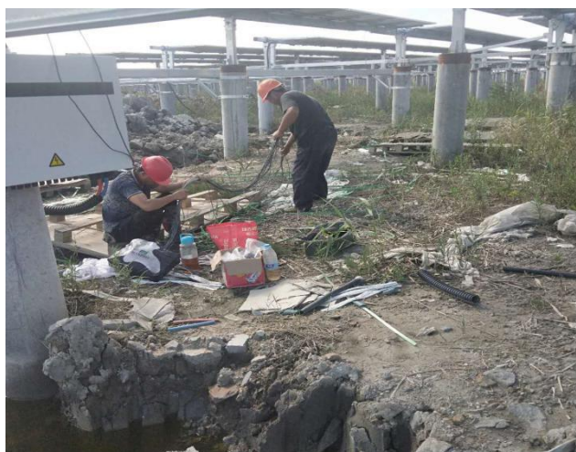
光伏区 6#汇流箱 MC4 插头制作
