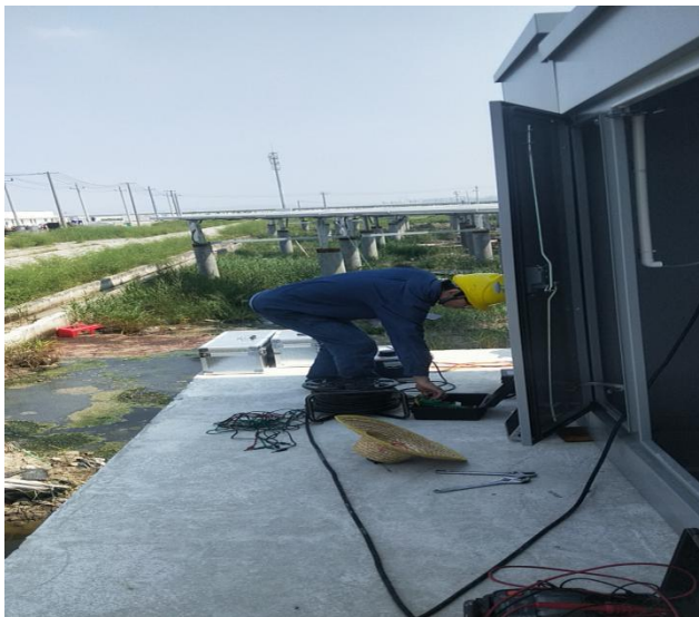
光伏区 1#箱变交流耐压测试
