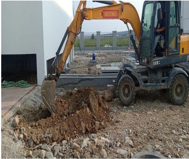
升压站地面平整
