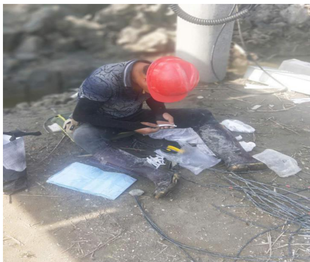
光伏区 7#线缆套号码管
