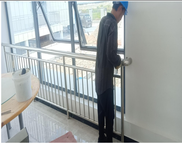
升压站窗户护栏安装
