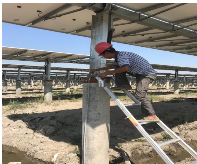
光伏区 15#接地防腐处理
