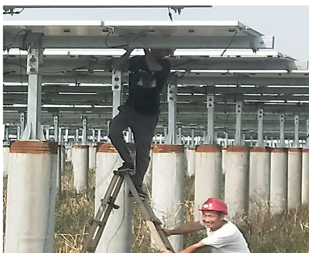
光伏区 9#组件连接线连接，电缆绑扎
