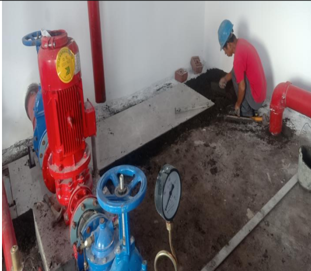
升压站消防泵房地砖铺设
