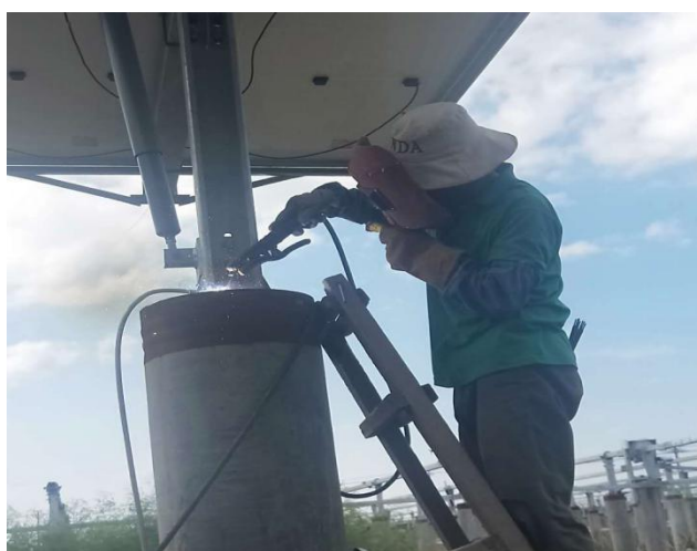
光伏区 3#接线焊接
