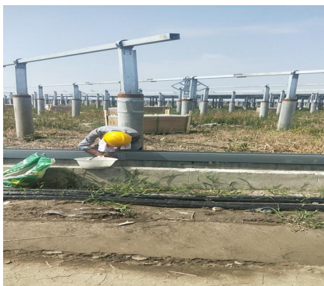
光伏区 27#桥架安装
