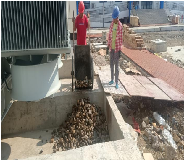
升压站主变积油池卵石填加
