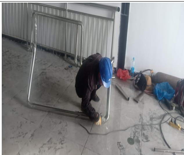
升压站窗户护栏制作
