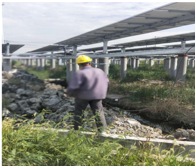
光伏区 7#485 通讯线敷设
