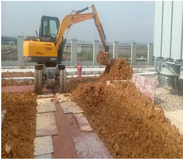
升压站场区绿化回填土
