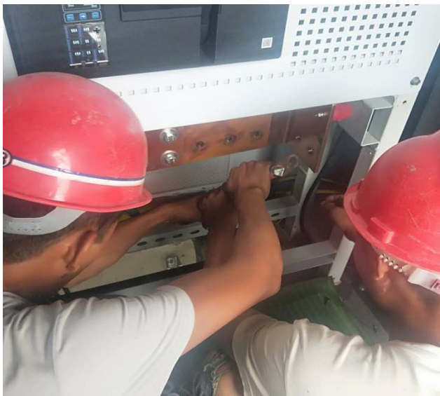
光伏区 12#低压电缆 185 接线
