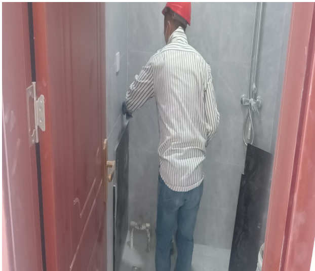
升压站卫浴安装
