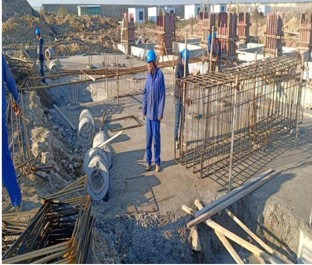
升压站主变基础钢筋绑扎 20191208
