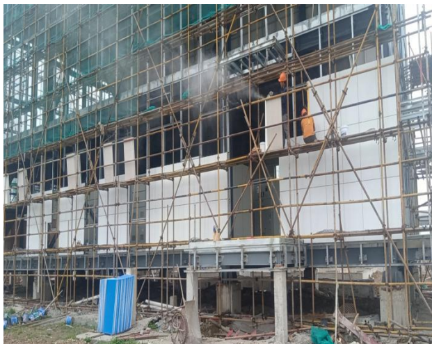
升压站配电楼外墙板安装
