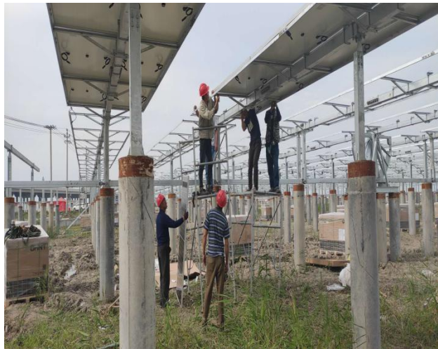
光伏区 3#组件安装
