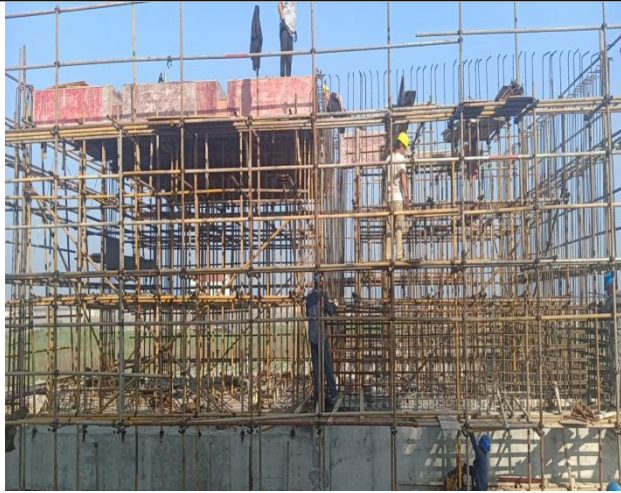
升压站消防水池模板支护
