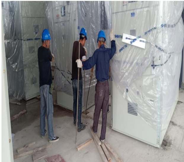
升压站 35KV 开关柜就位
