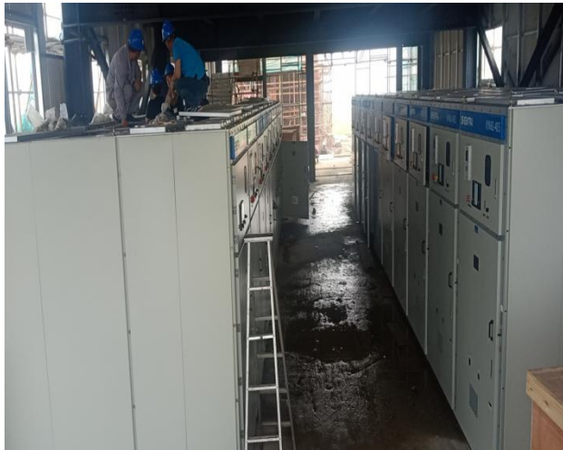
升压站 35KV 高压柜母线安装
