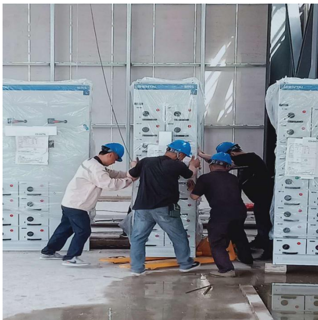
升压站低压配电柜就位
