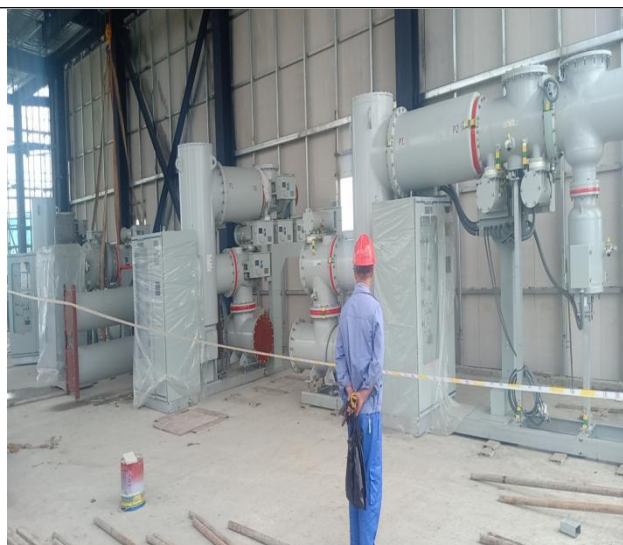
升压站 GIS 设备就位
