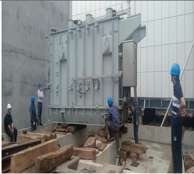
升压站 1#主变就位
