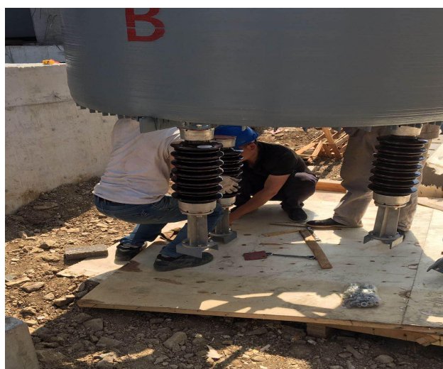
升压站电抗器就位
