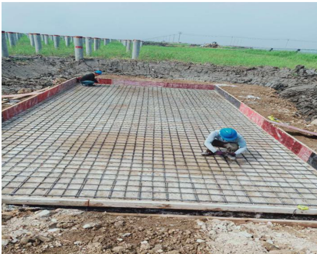
光伏区箱变基础钢筋绑扎
