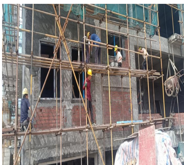
升压站综合楼外墙粉刷
