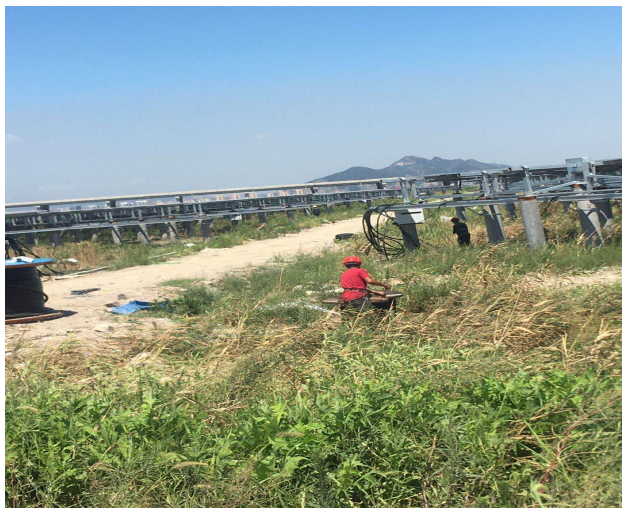
光伏区直流电缆敷设
