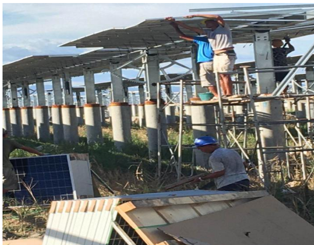
光伏区 31#组件安装
