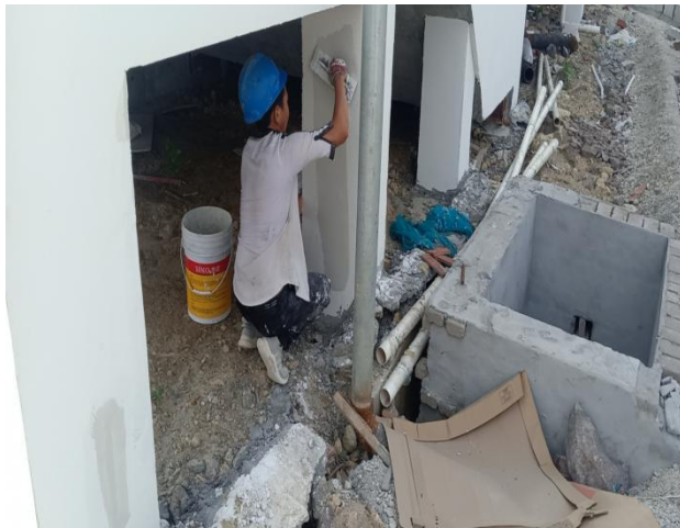
升压站配电楼架空层立柱抹灰
