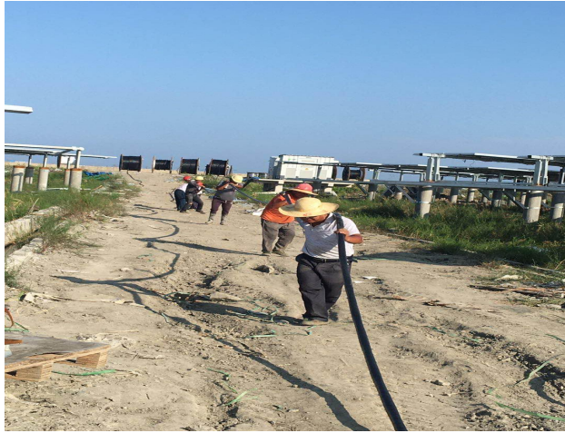
光伏区 35#低压电缆敷设
