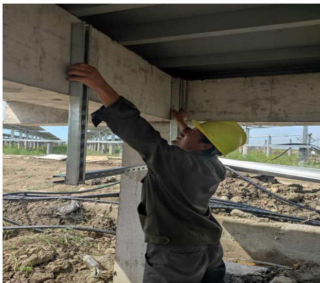
光伏区 22#低压交流电缆桥架支架安装
