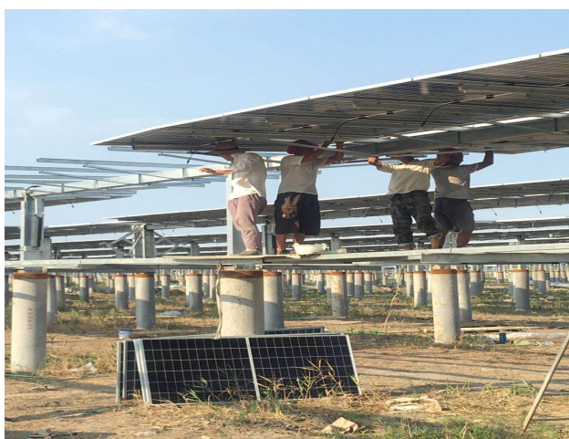
光伏区 30#组件安装
