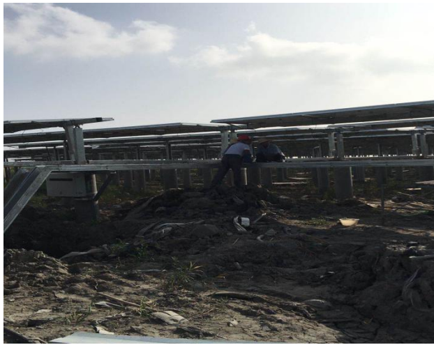
光伏区 35#桥架安装
