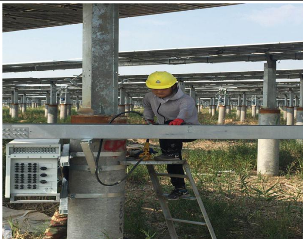
光伏区 25#桥架开孔
