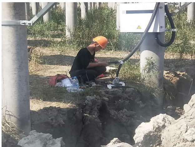
光伏区 6#汇流箱端 MC4 接头制作
