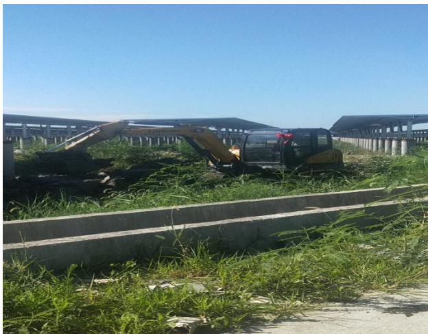
光伏区 8#环网接地沟开挖
