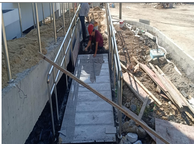
升压站综合楼坡道贴砖
