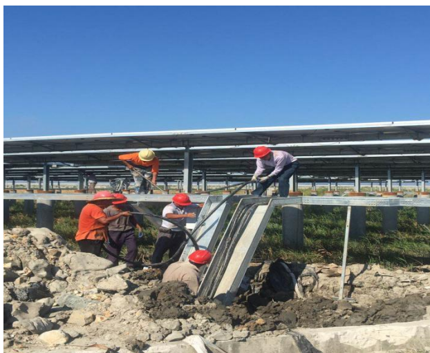
光伏区 37#低压电缆敷设
