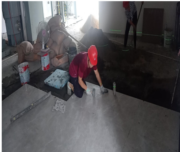
升压站配电装置楼 GIS 室地砖铺设
