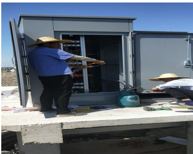
光伏区 23 地块箱变低压电缆接线
