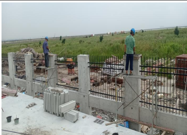
升压站围墙立柱顶部抹灰
