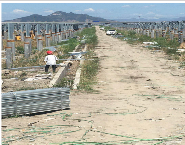
光伏区 31#逆变器支架安装
