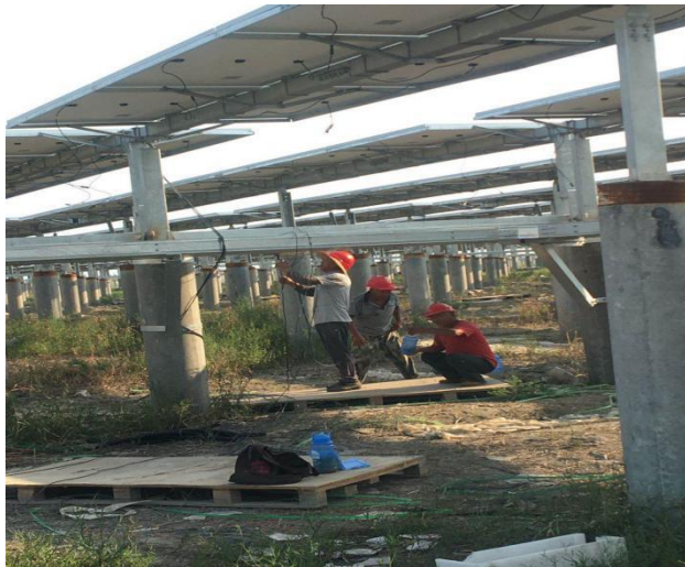
光伏区 34#光伏电缆敷设
