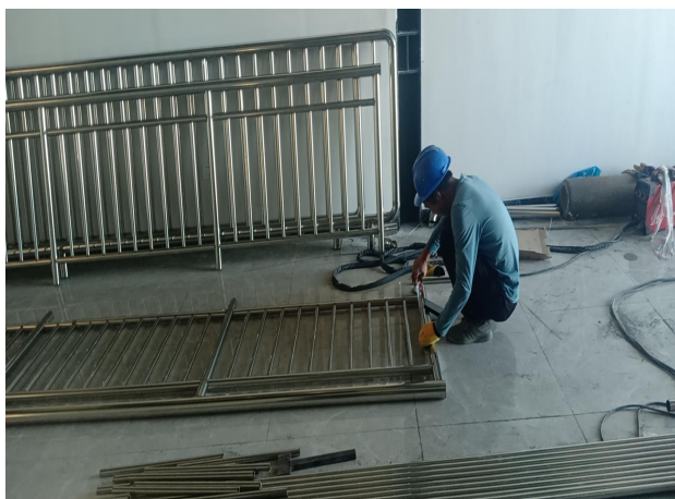
升压站配电楼围栏制作
