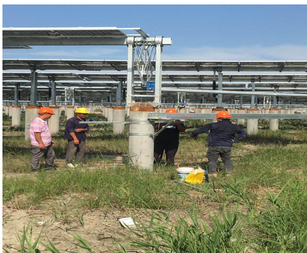
光伏区 30#桥架安装
