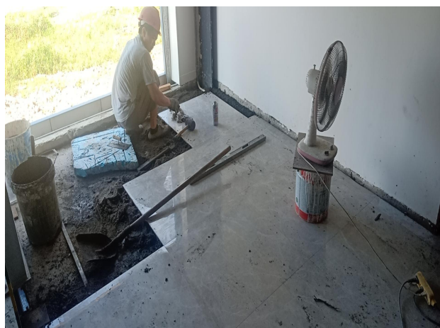
升压站配电楼一层地砖铺设
