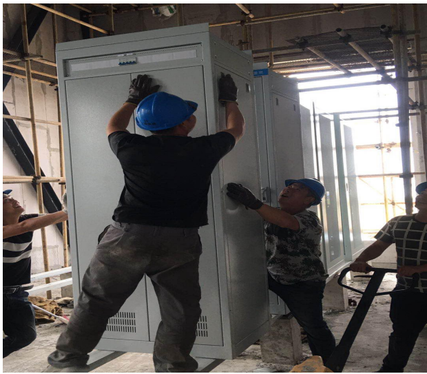
升压站二次盘柜就位
