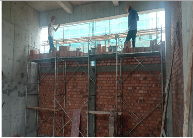
SVG 室墙体砌筑
