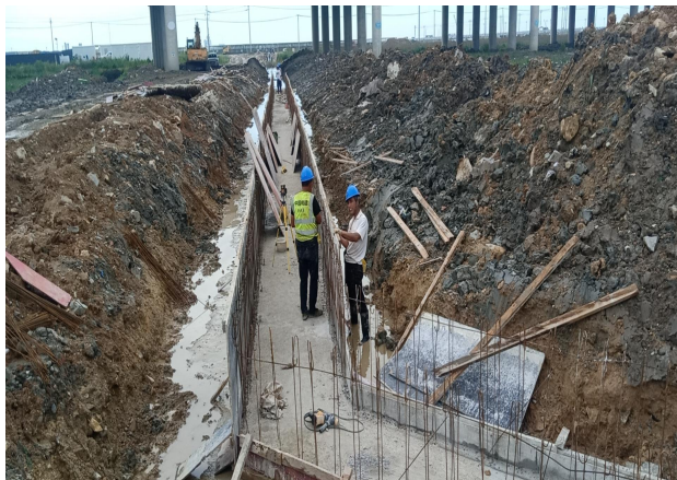
第二段集电线路电缆沟模板支护
