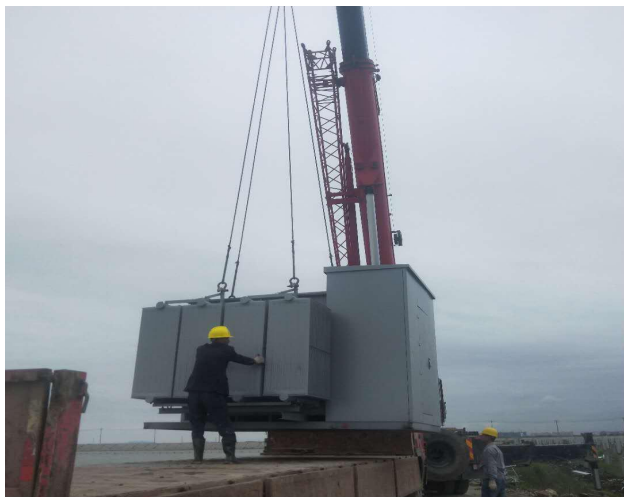
光伏区 27#箱变就位
