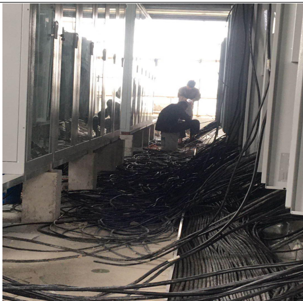
升压站配电楼二次电缆敷设
