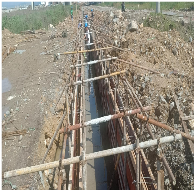
集电线路电缆沟模板支护
