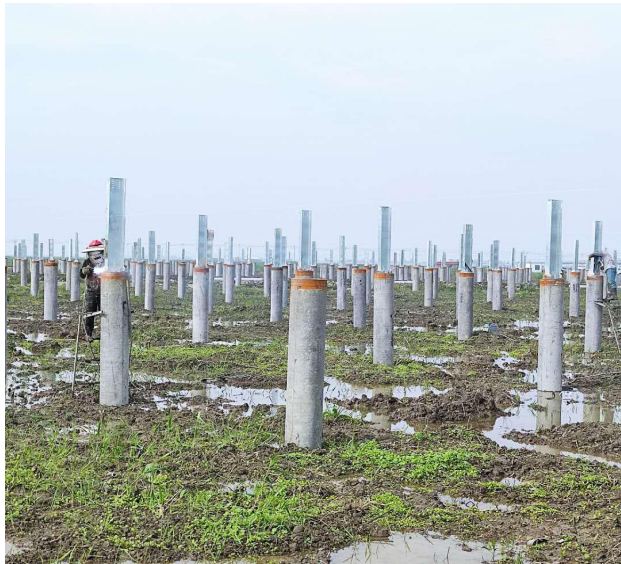
光伏区 20#柱头焊接
