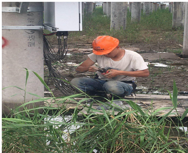
光伏区 2#汇流箱 MC4 接头制作
