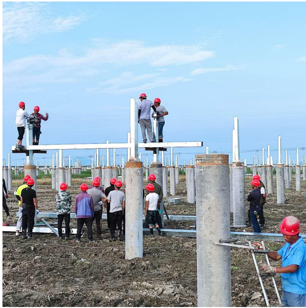
光伏区 14#支架试装
