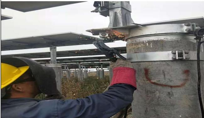
5# 立柱加固垫板焊接
