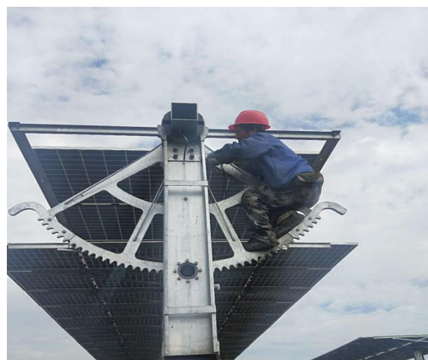
24#组件支架螺 丝紧固
