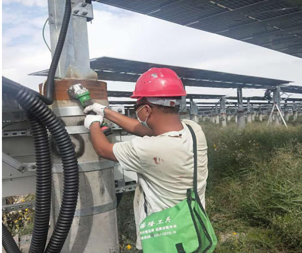
24#柱头防腐除锈
