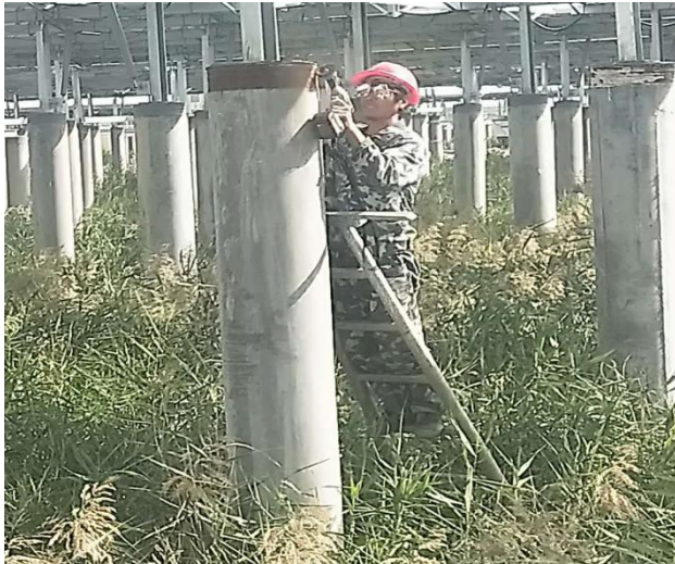
3# 柱头防腐除 锈
