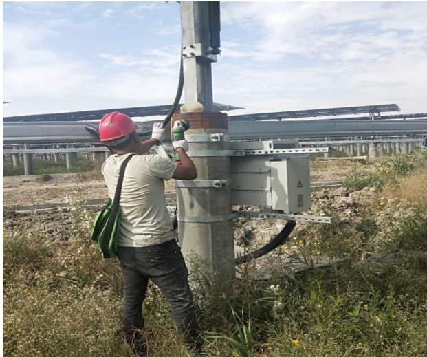
24#柱头防腐除锈
