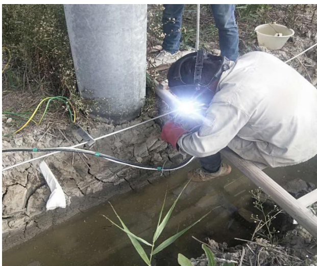
7# 主网接地焊 接
