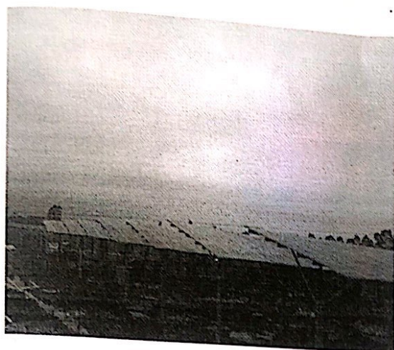
工程影像图片:
