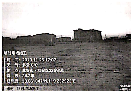
临时堆场施工
