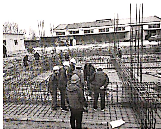
检查升压站基础绑筋
